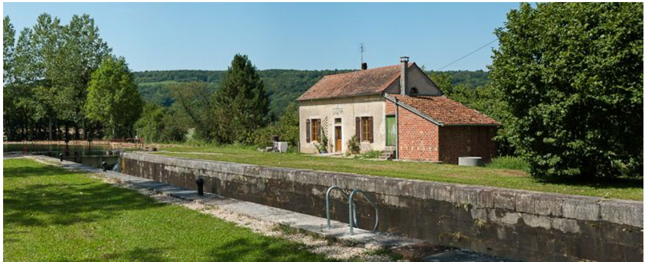
Vue d'ensemble du site d'écluse.
