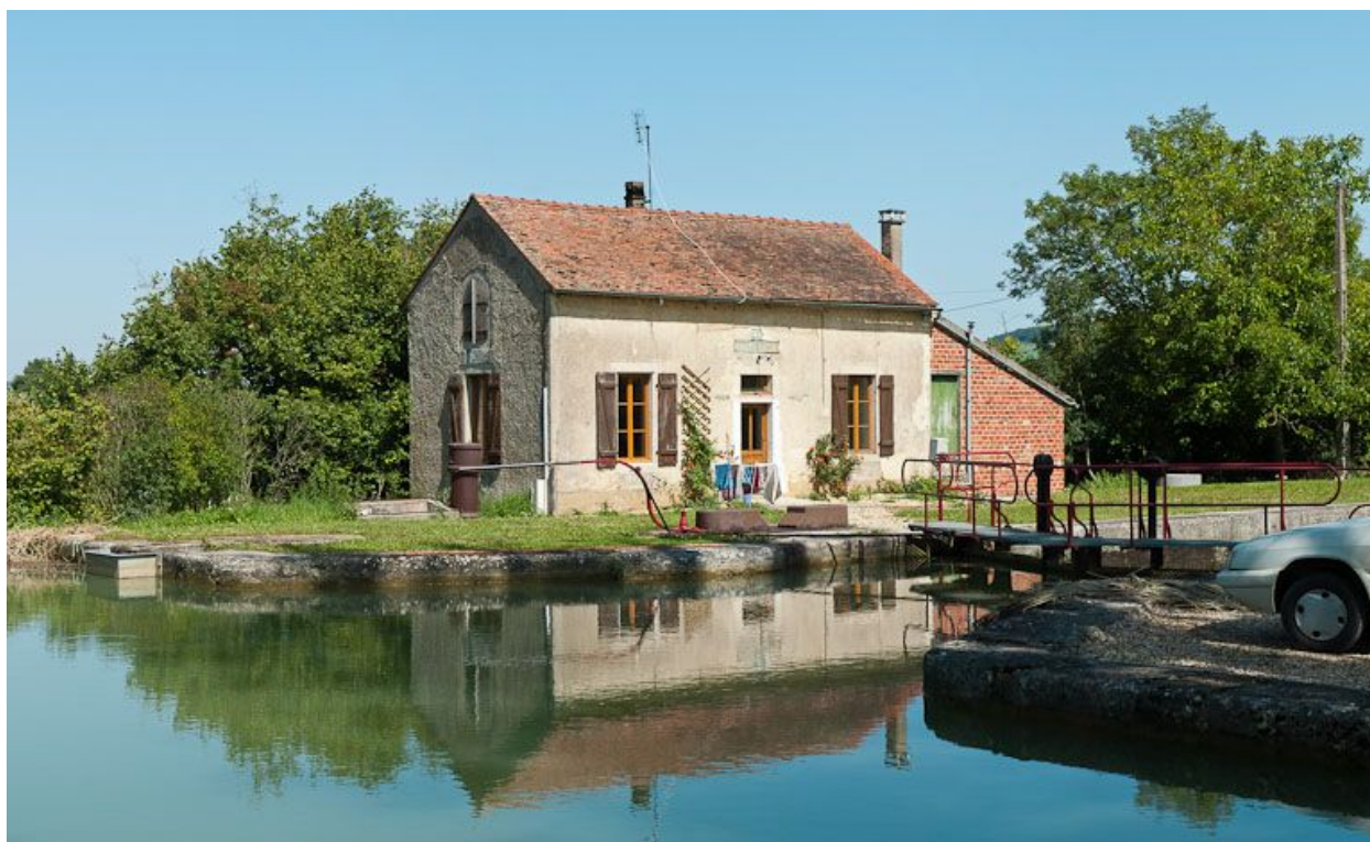
Vue du site d'écluse depuis l'amont.
