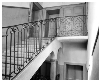
Intérieur : vue générale de l'escalier.
