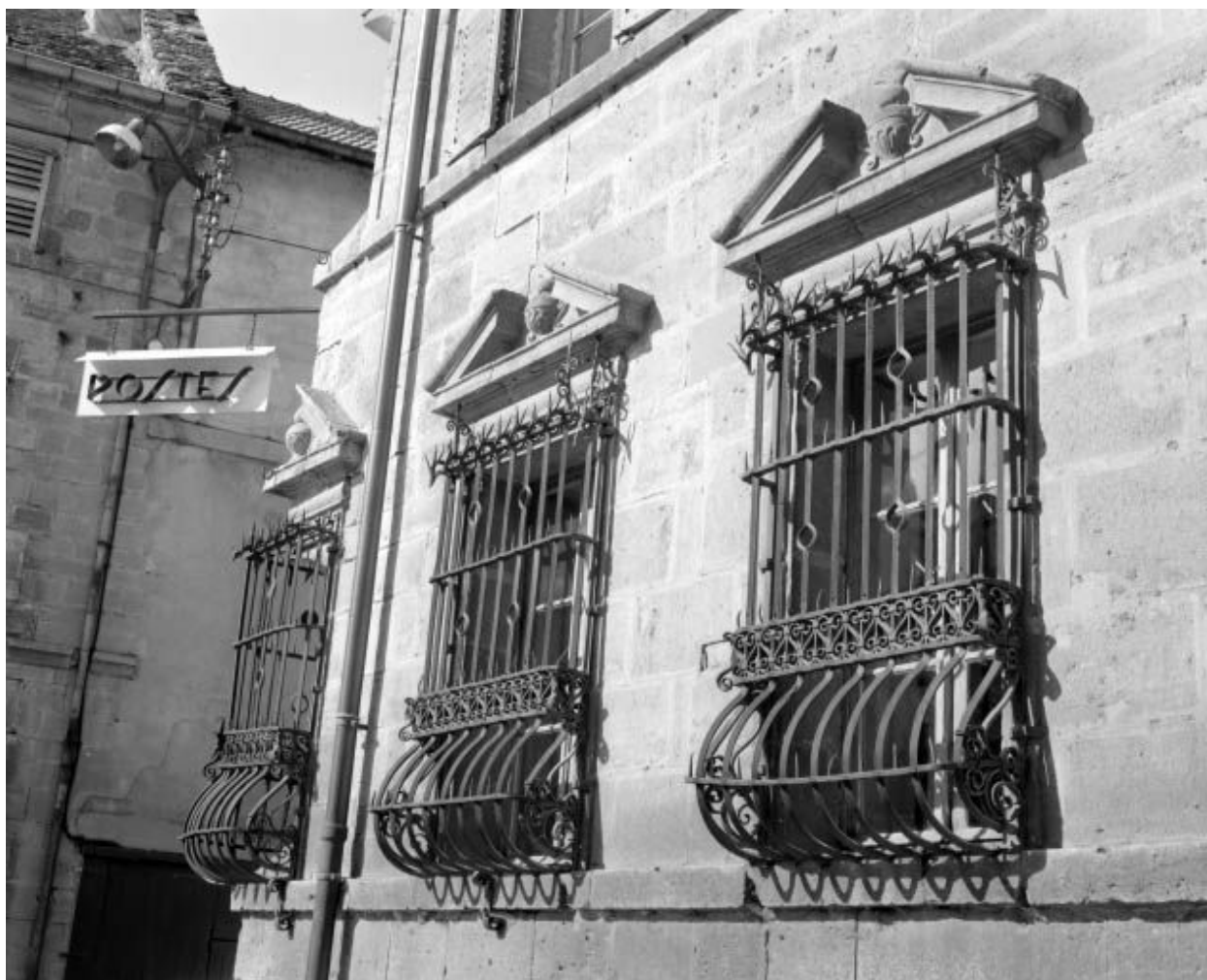
Façade antérieure, détail : baies du rez-de-chaussée, vue de trois quarts droit.
