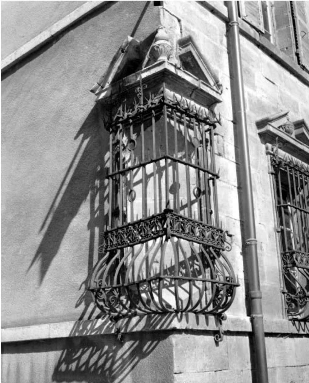
Façade antérieure, détail : baie d'angle du rez-de-chaussée.
