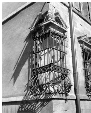
Façade antérieure, détail : baie d'angle du rez-de-chaussée. Phot. Yves Sancey IVR43_19772500114X
