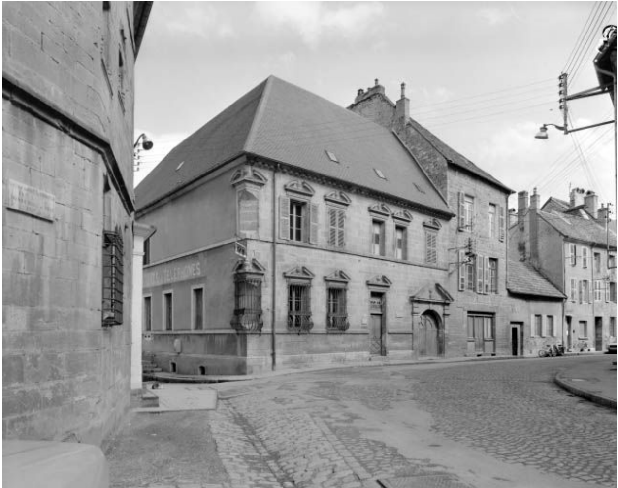
Façade antérieure et façade latérale gauche.
