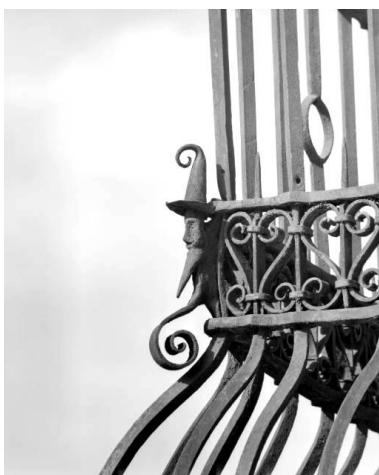
Façade antérieure, détail de la baie d'angle du rez-de-chaussée.
