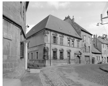
Façade antérieure et façade latérale gauche. Phot. Yves Sancey IVR43_19772500061V
