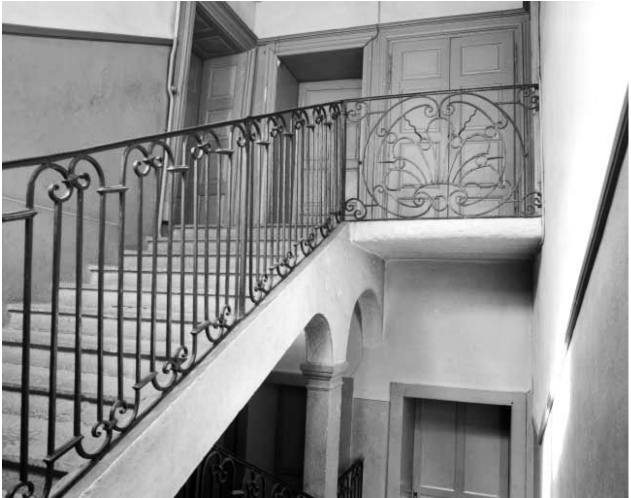
Intérieur : vue générale de l'escalier.
