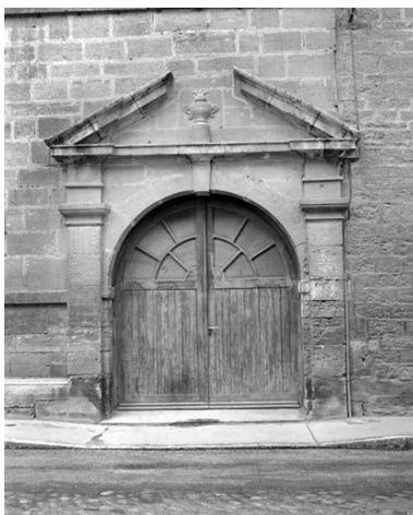
Façade antérieure : porte cochère.
