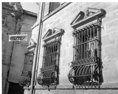
Façade antérieure, détail : baies du rez-de-chaussée, vue de trois quarts droit. Phot. Yves Sancey IVR43_19772500115X
