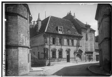
Façade antérieure et façade latérale gauche [1re moitié 20e siècle]. Autr. Jules Manias IVR43_20062500941PY
