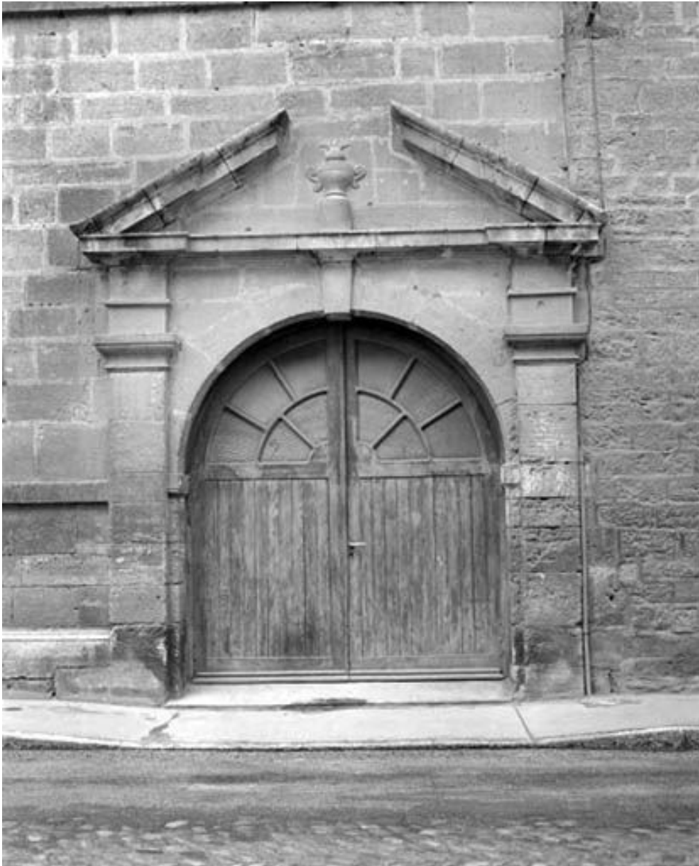
Façade antérieure : porte cochère.
