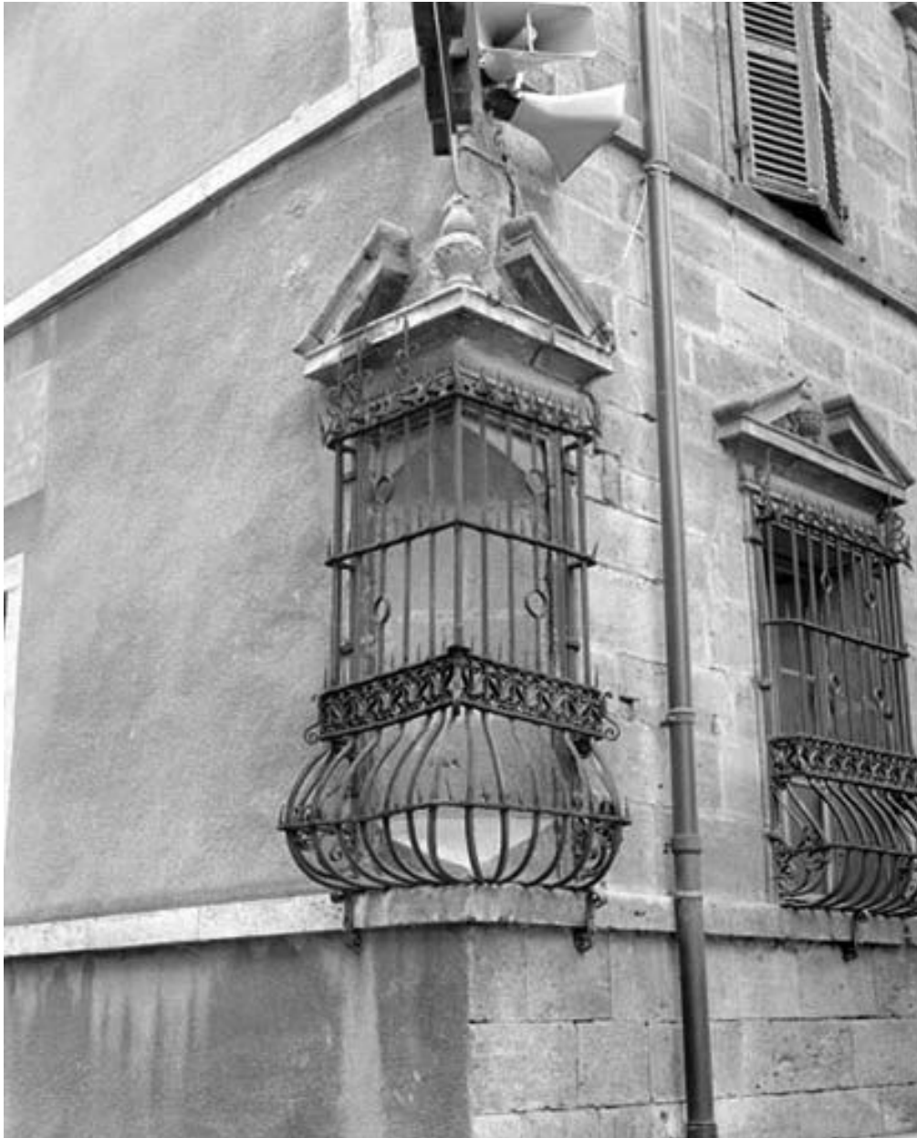
Façade antérieure, détail : baie d'angle et 1ère baie du rez-de-chaussée.
