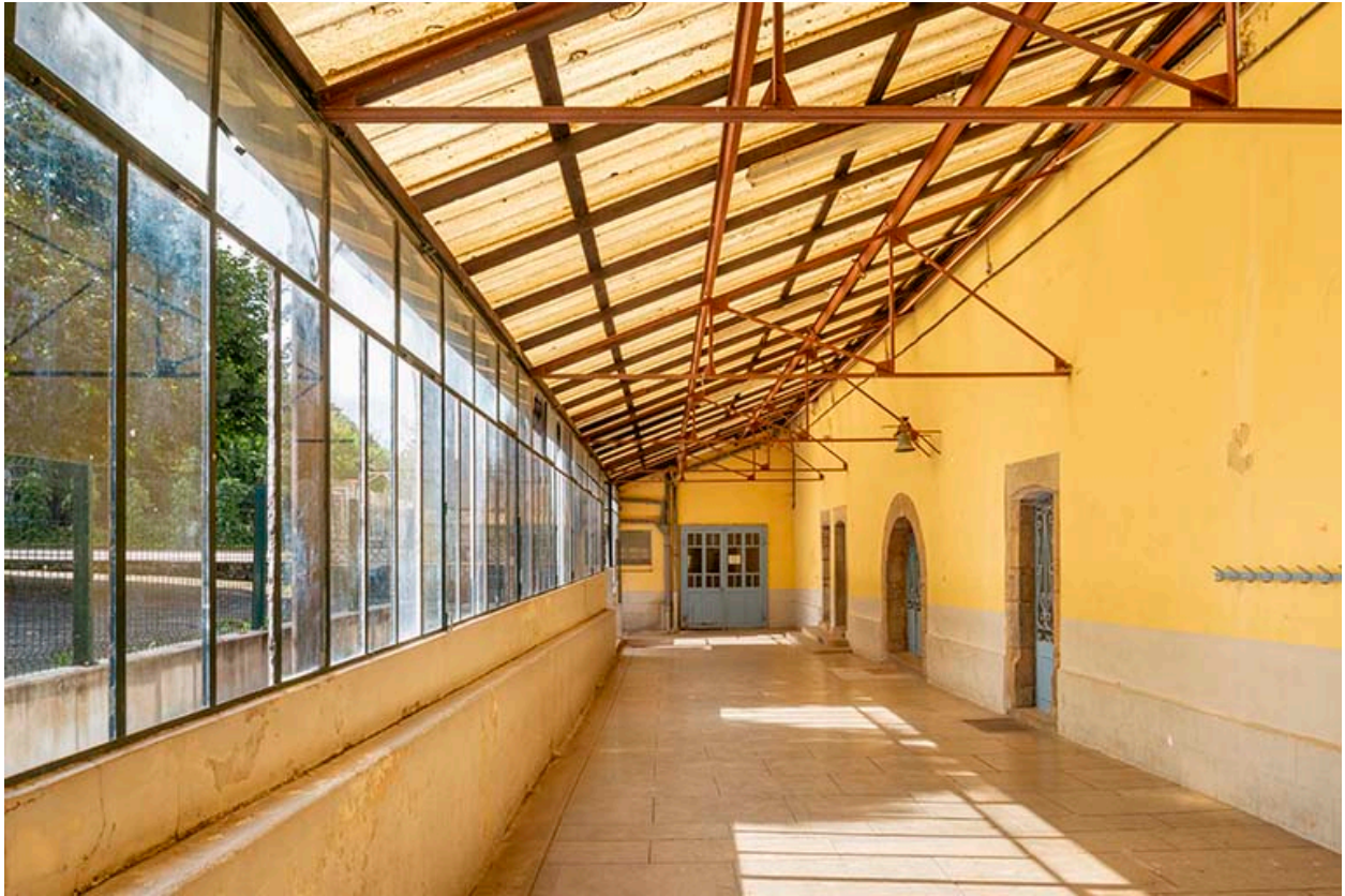
Galerie couverte, adossée contre la façade est du bâtiment conventuel.
