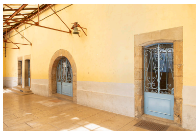
Bâtiment conventuel. Ouvertures de la façade est. Phot. Jérôme Mongreville IVR43_20243900840NUC4A
