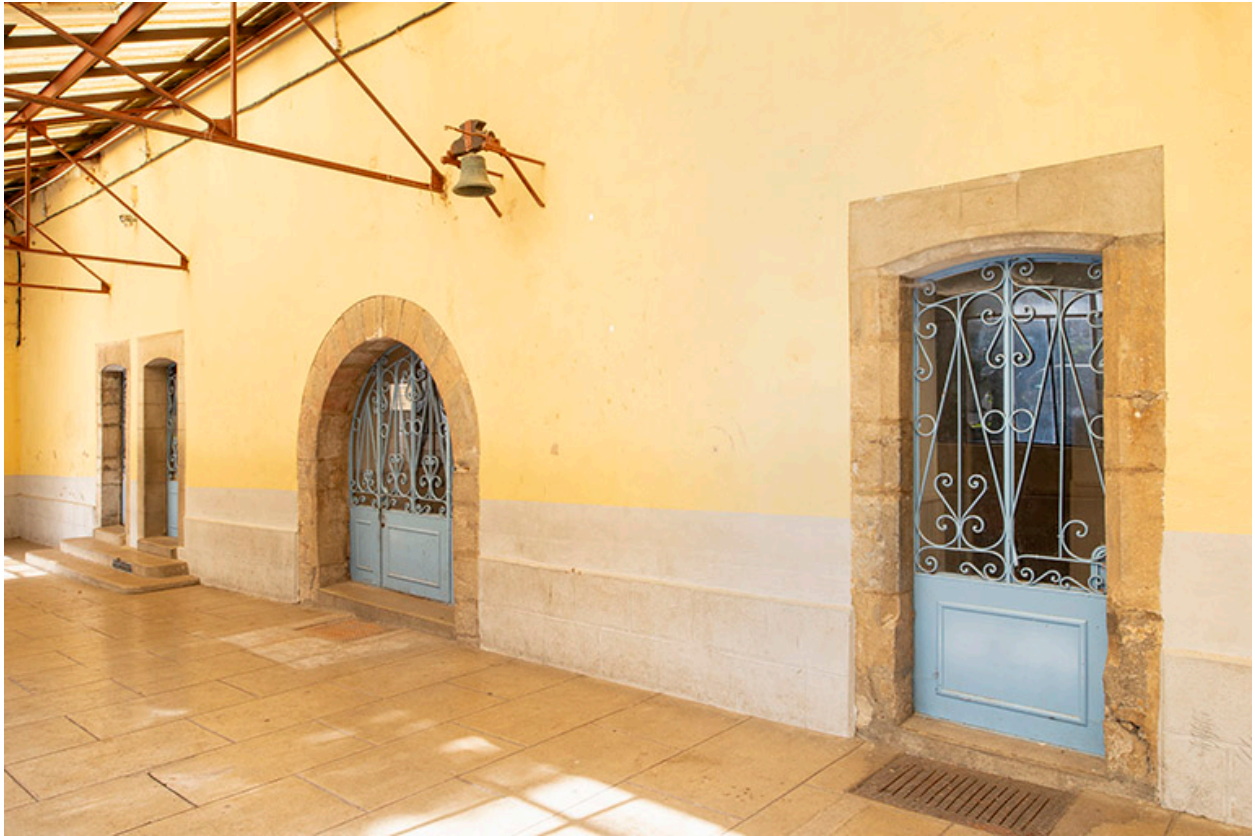
Bâtiment conventuel. Ouvertures de la façade est.
