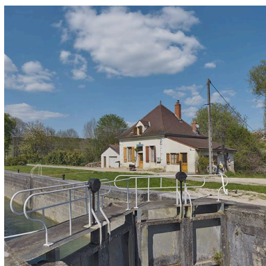
Maison éclusière vue d'aval. Phot. Thierry Kuntz IVR26_20112102597NUC4A
