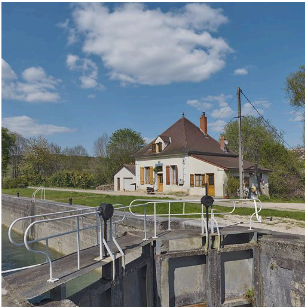
Maison éclusière vue d'aval.
