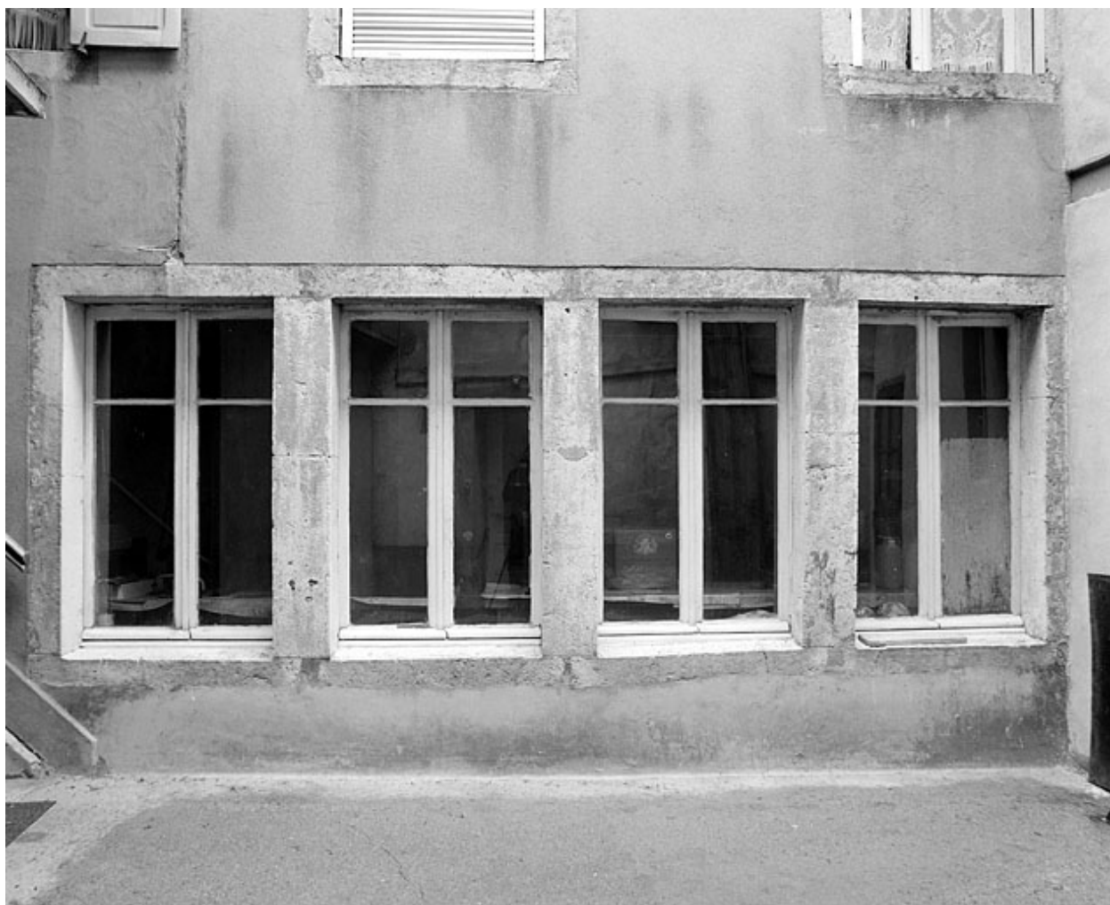
Aile sud : fenêtres jumelées.
