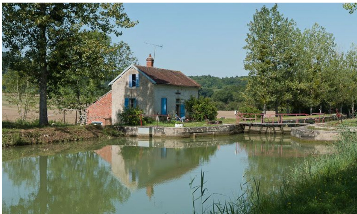
Vue du site d'écluse depuis l'amont.
