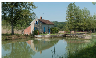
Vue du site d'écluse depuis l'amont. Phot. Pierre-Marie Barbe-Richaud IVR26_20112103900NUC4AQ
