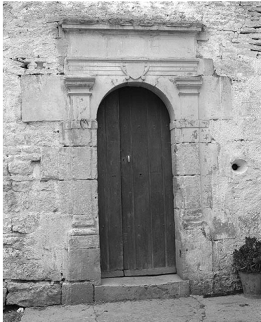
Porte d'entrée de la tour. Phot. Michel Thierry IVR26_19748901033X
