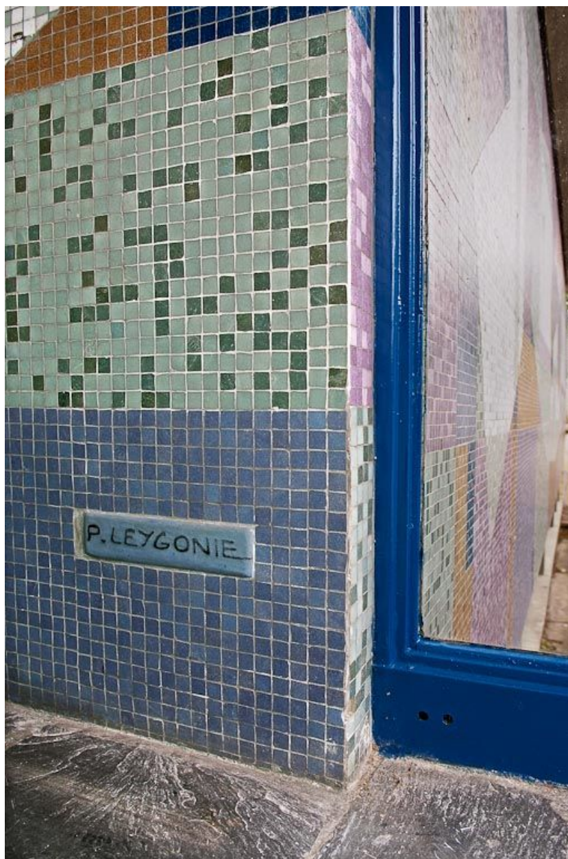
Mur du hall d'entrée, détail, signature : P. LEYGONIE.
