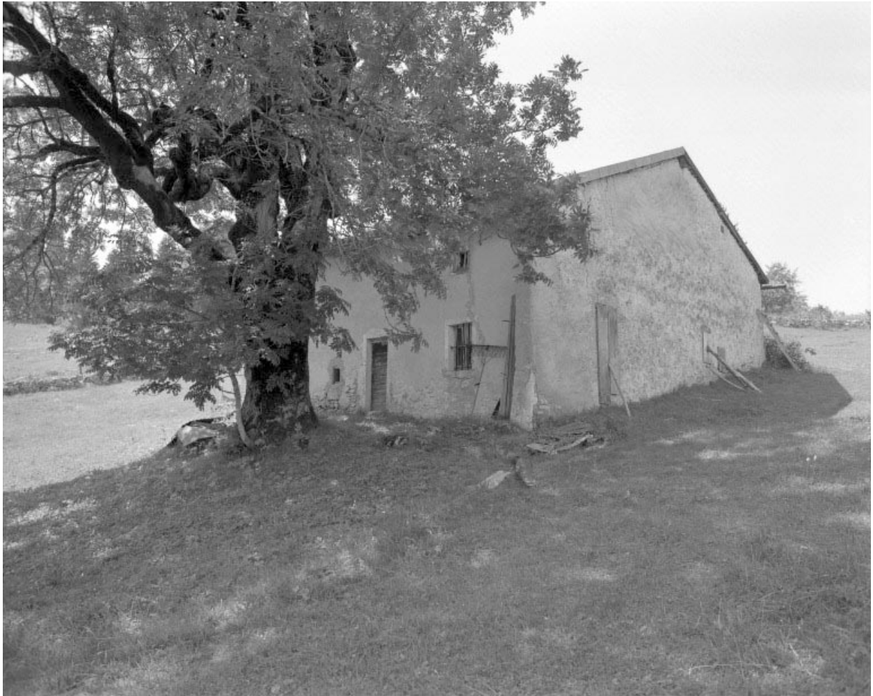
Façade antérieure et face droite.
