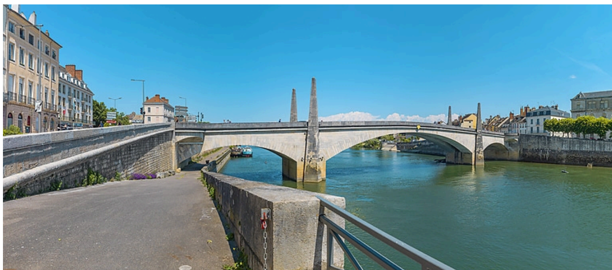
Vue d'ensemble du pont, depuis la banquette de halage aval.
