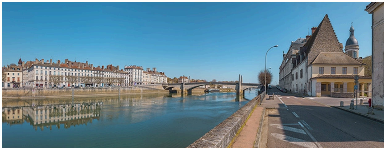
Le pont vu d'aval.
