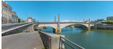
Vue d'ensemble du pont, depuis la banquette de halage aval. Phot. Thierry Kuntz IVR26_20217100269NUC4A
