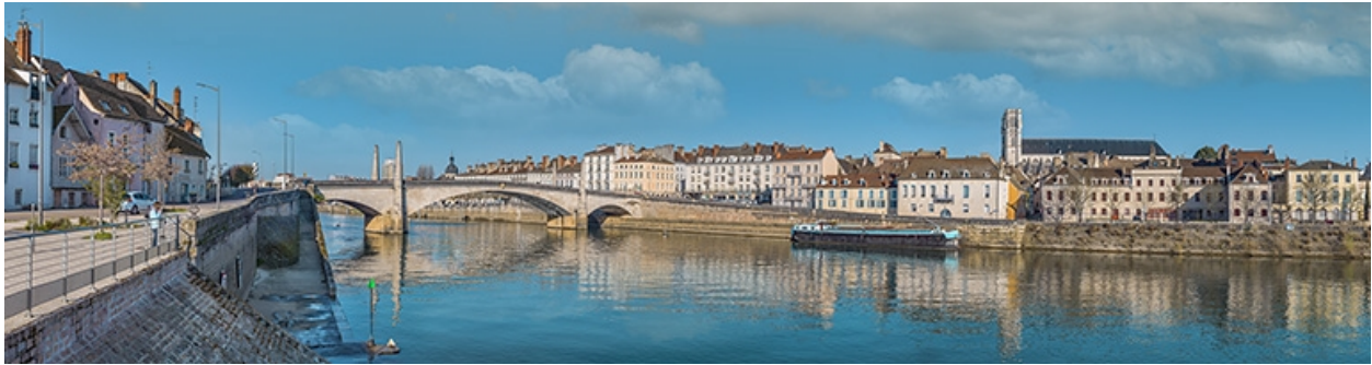
Vue d'ensemble depuis l'amont.
