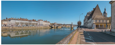
Le pont vu d'aval. Phot. Thierry Kuntz IVR26_20217100064NUC4A
