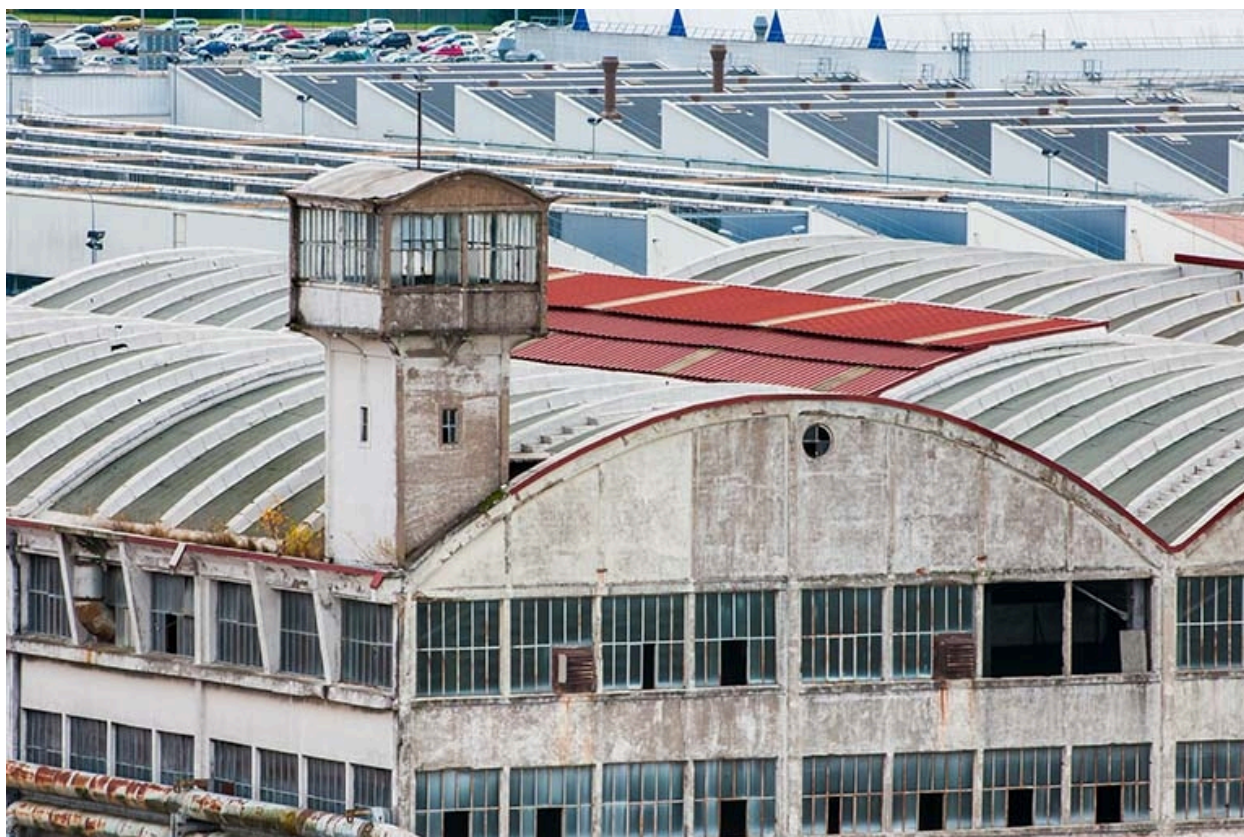
Toitures de l'usine Peugeot de Sochaux-Montbéliard.
