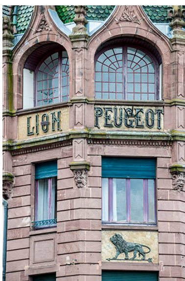
Immeuble Peugeot, place du Général de Gaulle (Montbéliard). Détail du bâtiment d'angle. Phot. Jérôme Mongreville IVR43_20132502797NUC4A
