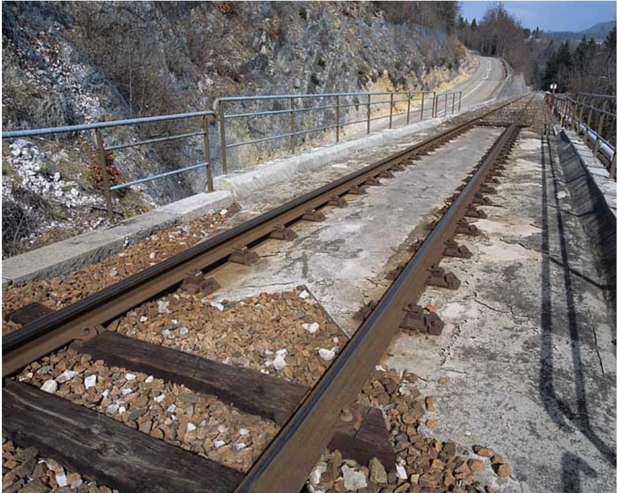
Système d'attaches directes sur le tablier.
