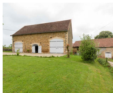
L'étable, vue de trois quart droite. Phot. Pierre-Marie Barbe-Richaud IVR26_20187100023NUC4AQ
