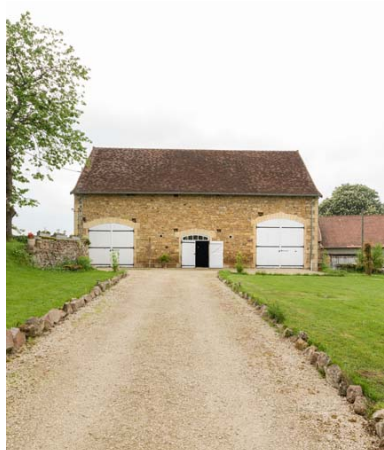
L'étable vue de face. Phot. Pierre-Marie Barbe-Richaud IVR26_20187100022NUC2A
