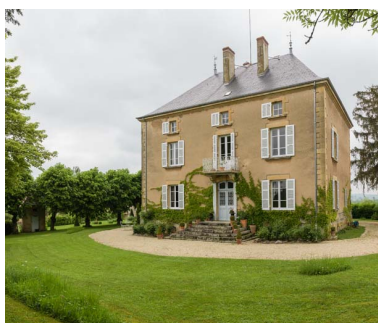
Façade postérieure, vue de trois quarts droite. Phot. Pierre-Marie Barbe-Richaud IVR26_20187100018NUC2A
