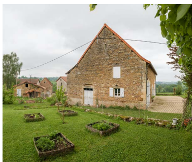
Pignon sud de l'étable. Phot. Pierre-Marie Barbe-Richaud IVR26_20187100024NUC4AQ
