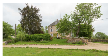
Maison d'habitation. Vue d'ensemble depuis le nord. Phot. Pierre-Marie Barbe-Richaud IVR26_20187100016NUC2AQ
