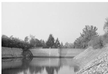
Barrage et bassin de retenue. Phot. Laurent Poupard IVR43_19913901107Z
