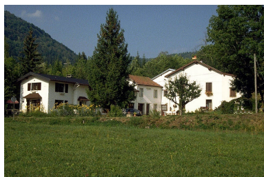
Vue d'ensemble depuis le sud. Phot. Laurent Poupard IVR43_19913901115ZA
