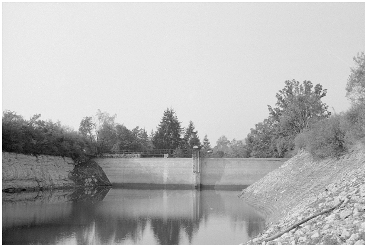
Barrage et bassin de retenue.
