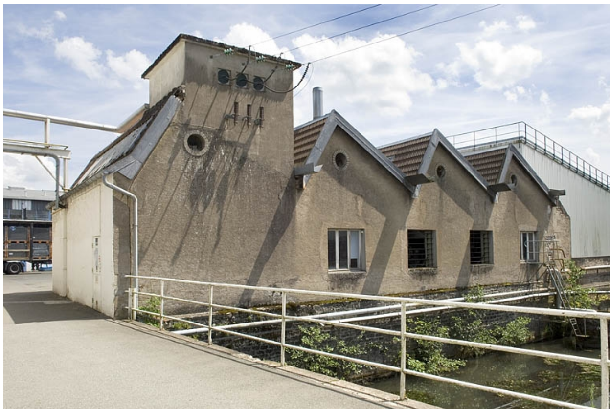
Atelier de réparation.
