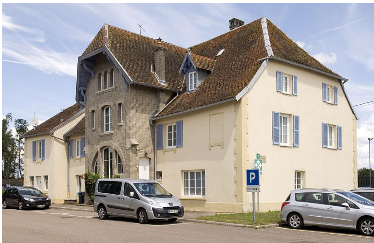
Logement patronal. Vue depuis le sud-ouest.
