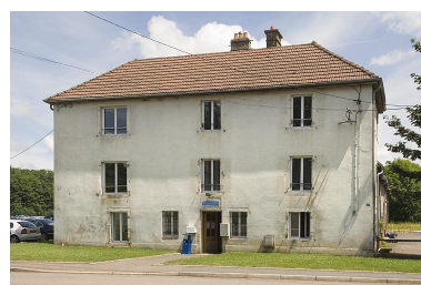
Bâtiment des commis. Façade ouest. Phot. Jérôme Mongreville IVR43_20097000536NUC2A
