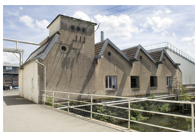
Atelier de réparation. Phot. Jérôme Mongreville IVR43_20097000550NUC2A
