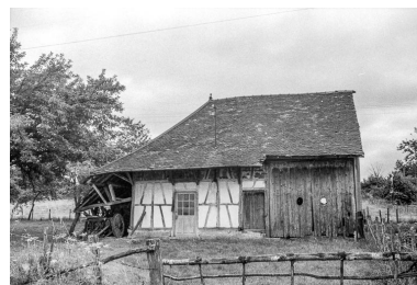
ferme cadastrée 1811 B 4 : vue générale. Phot. Guy Forestier IVR43_19753900198Z
