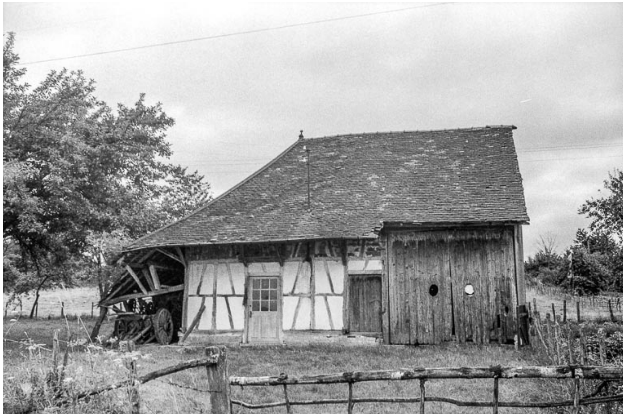
ferme cadastrée 1811 B 4 : vue générale.
