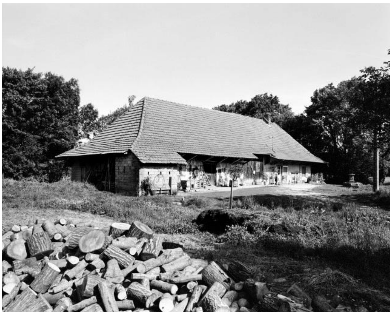
Ferme située au lieudit Vizent : vue générale.
