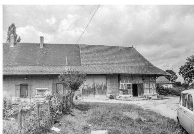
Ferme et son jardin : partie droite. Phot. Guy Forestier IVR43_19753900202Z
