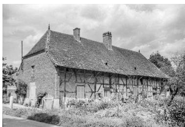
Ferme : vue générale. Phot. Guy Forestier IVR43_19753900205Z
