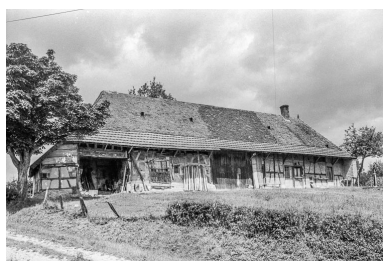
Ferme : vue générale. Phot. Guy Forestier IVR43_19753900203Z
