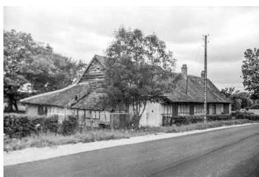
Ferme : vue générale. Phot. Guy Forestier IVR43_19753900199Z
