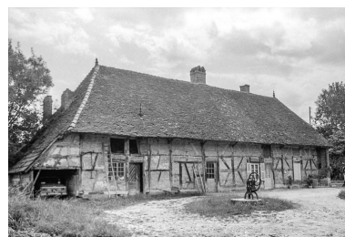
Ferme : face postérieure. Phot. Guy Forestier IVR43_19753900204Z
