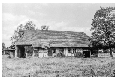
Ferme : vue générale. Phot. Guy Forestier IVR43_19753900200Z
