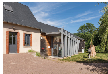
Façade antérieure, de trois quarts gauche. Phot. Pierre-Marie Barbe-Richaud IVR26_20257101106NUC4A
