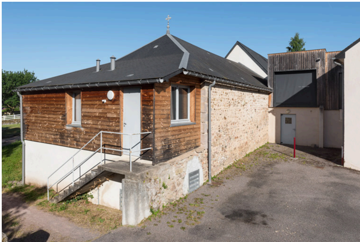
Façades postérieure et latérale gauche.
