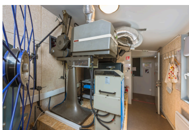
Cabine de projection. Au centre le projecteur argentique Fedi XV T et son redresseur Irem. Phot. Pierre-Marie Barbe-Richaud IVR26_20257100898NUC4A
