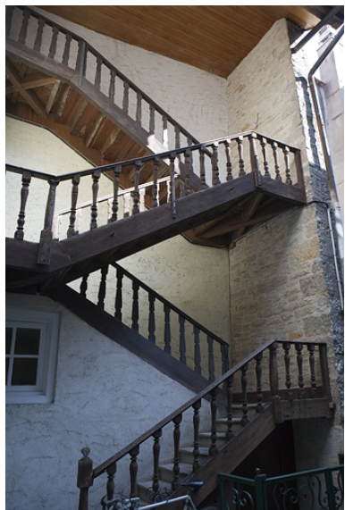
Détail de l'escalier à cage ouverte du logis secondaire. Phot. Yves Sancey IVR43_20092501377NUC2A
