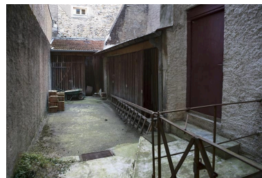
Vue d'ensemble des bûchers dans la deuxième cour. Phot. Yves Sancey IVR43_20092501380NUC2A
