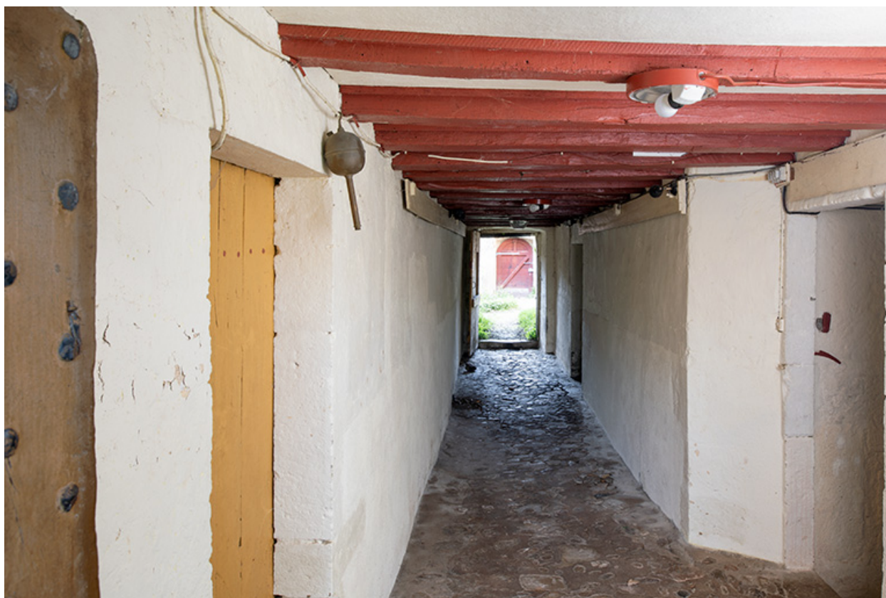
Couloir du rez-de-chaussée, vu depuis le jardin.
