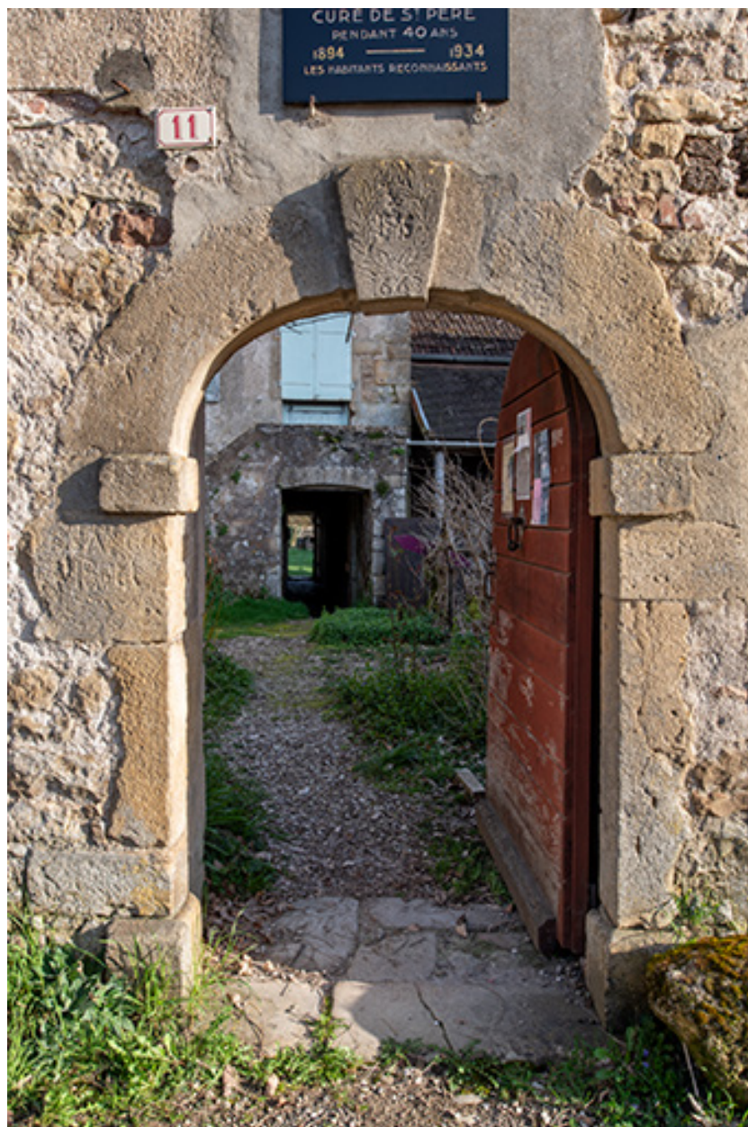
La porte piétonne du mur de clôture.
