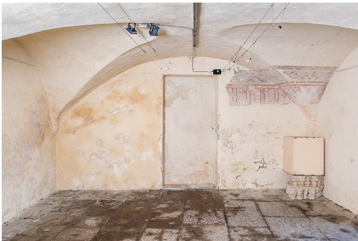
Cellier du rez-de-chaussée, depuis le couloir vers le fond.
