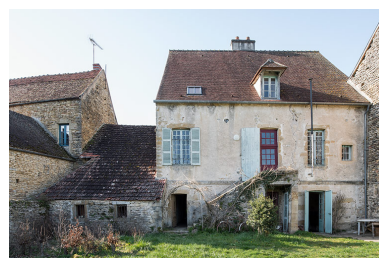
Le presbytère et la remise depuis le jardin. Phot. Nicolas Waltefaugle IVR26_20268900030NUC4A
