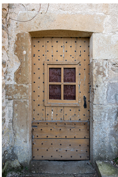
Porte d'accès au couloir du rez- de-chaussée, vue depuis le jardin. Phot. Nicolas Waltefaugle
