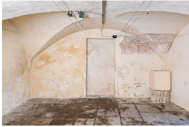
Cellier du rez-de-chaussée, depuis le couloir vers le fond. Phot. Nicolas Waltefaugle IVR26_20268900040NUC4A
