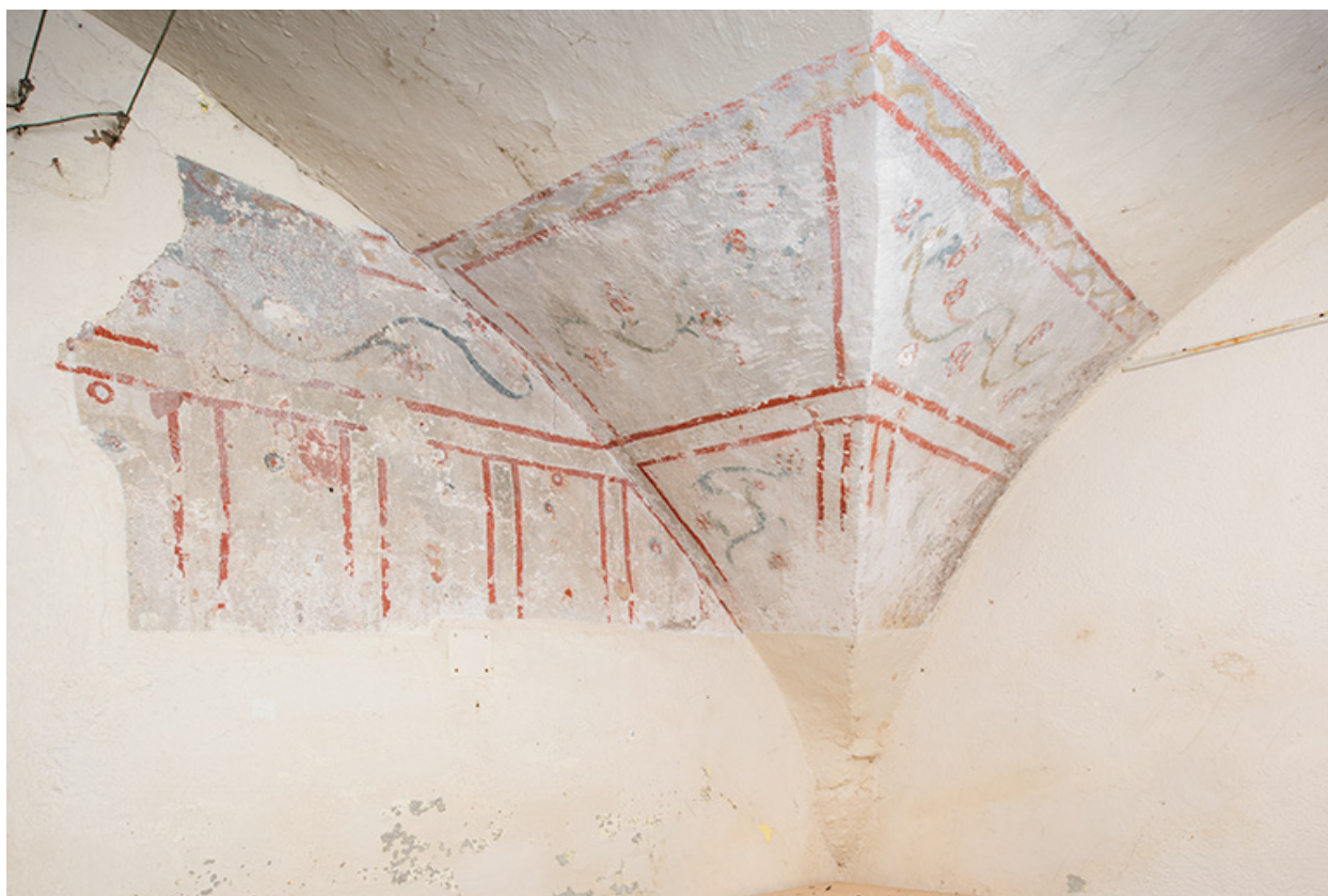
Vestiges dégagés de peintures murales sur la voûte du cellier.
