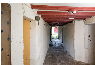
Couloir du rez-de- chaussée, vu depuis le jardin. Phot. Nicolas Waltefaugle IVR26_20268900033NUC4A
