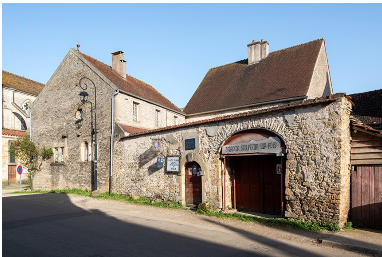
Le mur de clôture depuis la rue.
