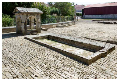
Lavoir et puits. Phot. Sonia Dourlot IVR43_20167001849NUC2A
