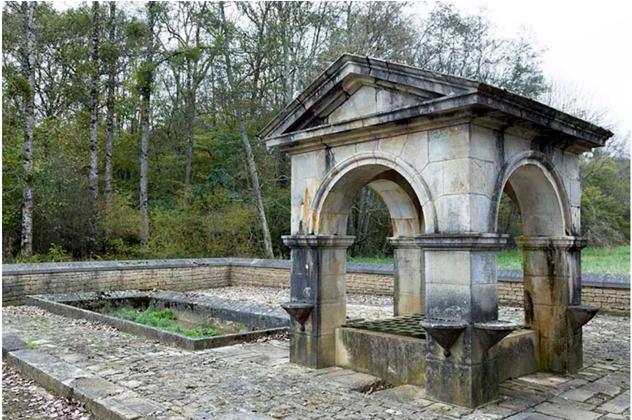
Puits et lavoir depuis l'abreuvoir.
