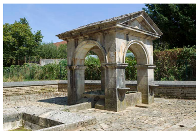
Puits et son édicule. Phot. Sonia Dourlot IVR43_20167001852NUC2A
