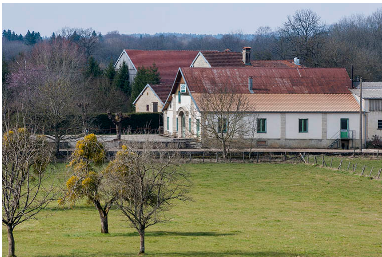
Façade nord de l'atelier de fabrication.
