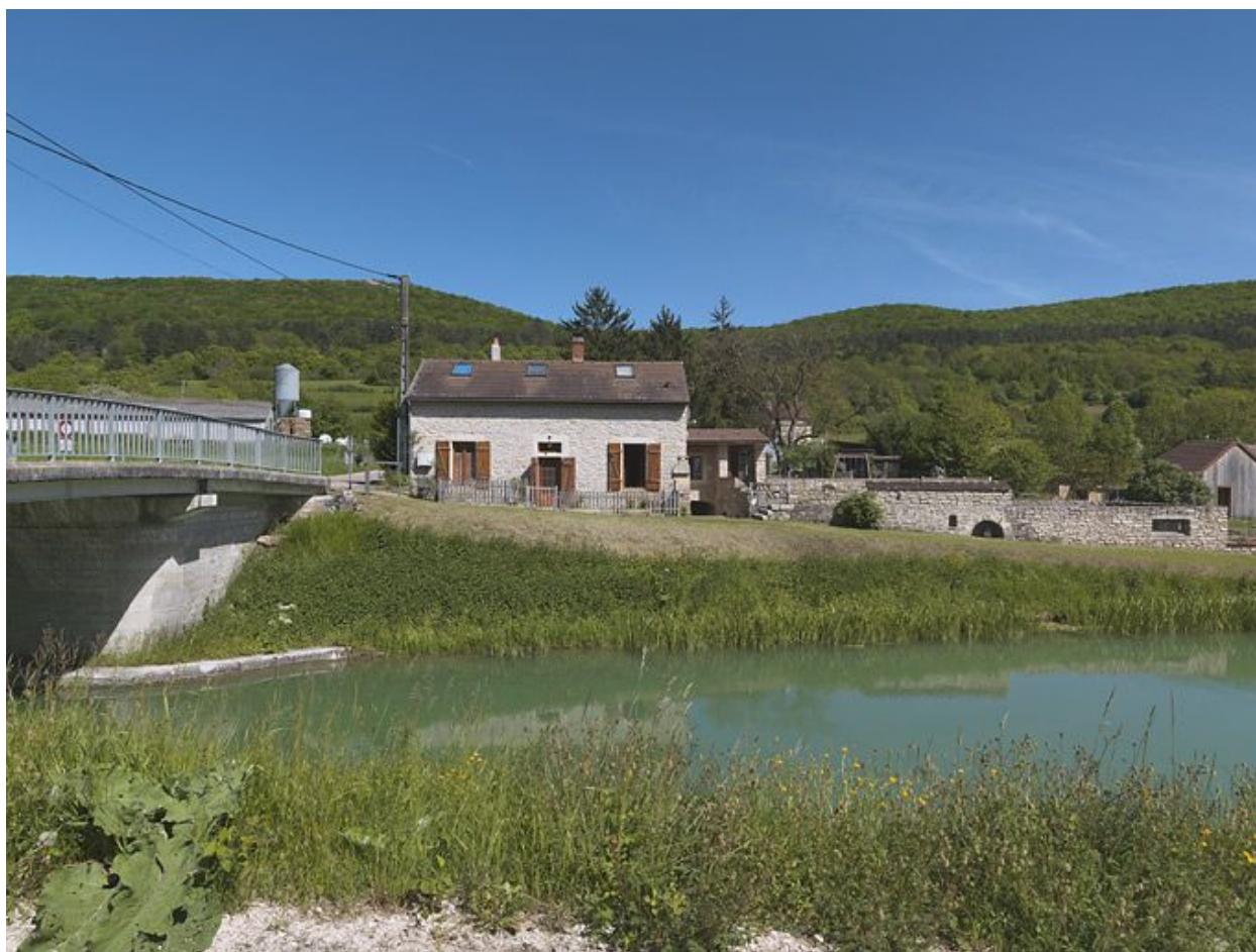
Maison de garde de face.
