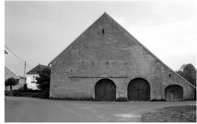
Façade latérale droite. Phot. Bernard Lardière IVR43_19797000056Z
