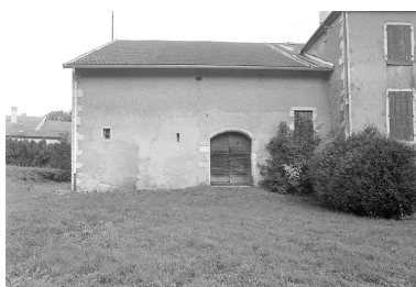
Façade de la ferme sur le parc. Phot. Jérôme Mongreville IVR43_19963901106X
