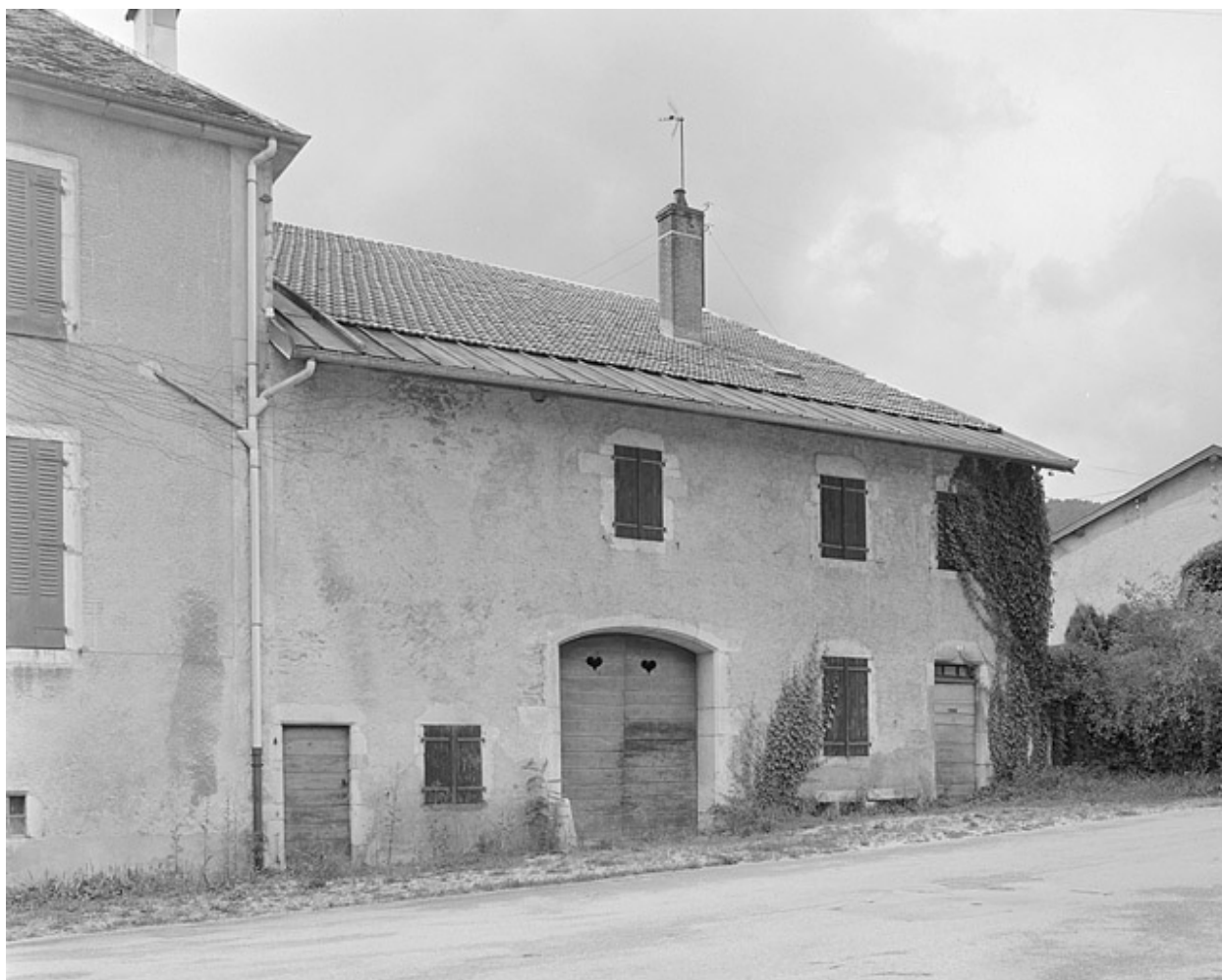
Face nord-est de la ferme.
