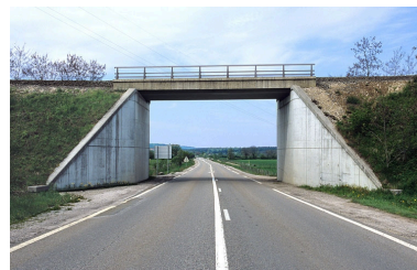
Vue d'ensemble, depuis l'est. Phot. Yves Sancey IVR43_20053900062ZA
