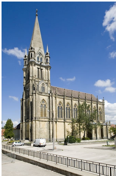
vue d'ensemble Phot. Jérôme Mongreville IVR43_20082500646NUC2A
