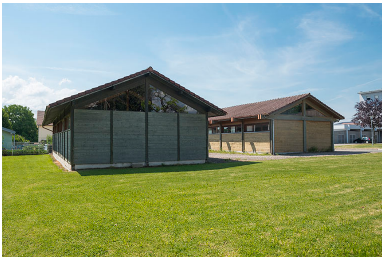
Angles nord-est des préfabriqués.
