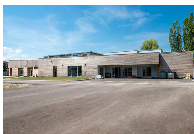
Façade nord-est de la cantine. Phot. Mary Ruffinoni IVR43_20147000055NUC4A
