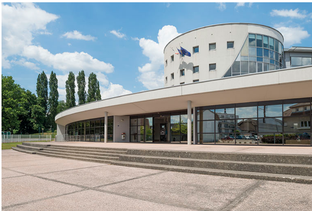
Place-parvis et entrée.
