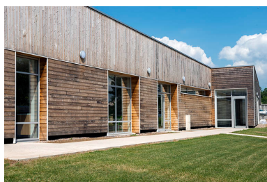
Détail de la façade est de la cantine. Phot. Mary Ruffinoni IVR43_20147000051NUC4A
