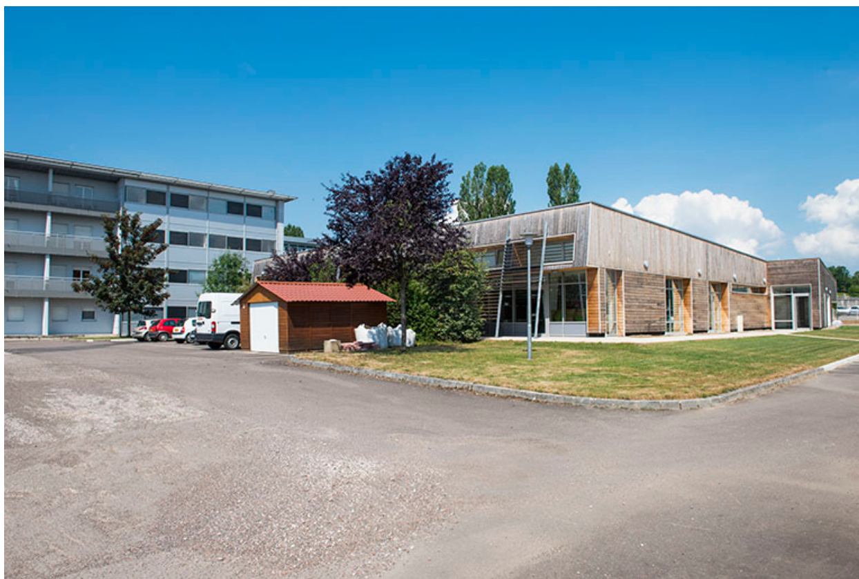
Angle sud-est de la cantine.
