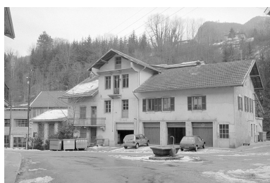
Minoterie et logements.
