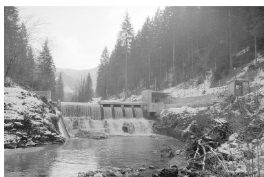
Barrage et prise d'eau.
