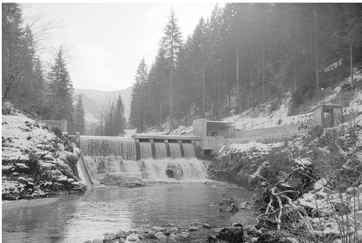
Barrage et prise d'eau.
