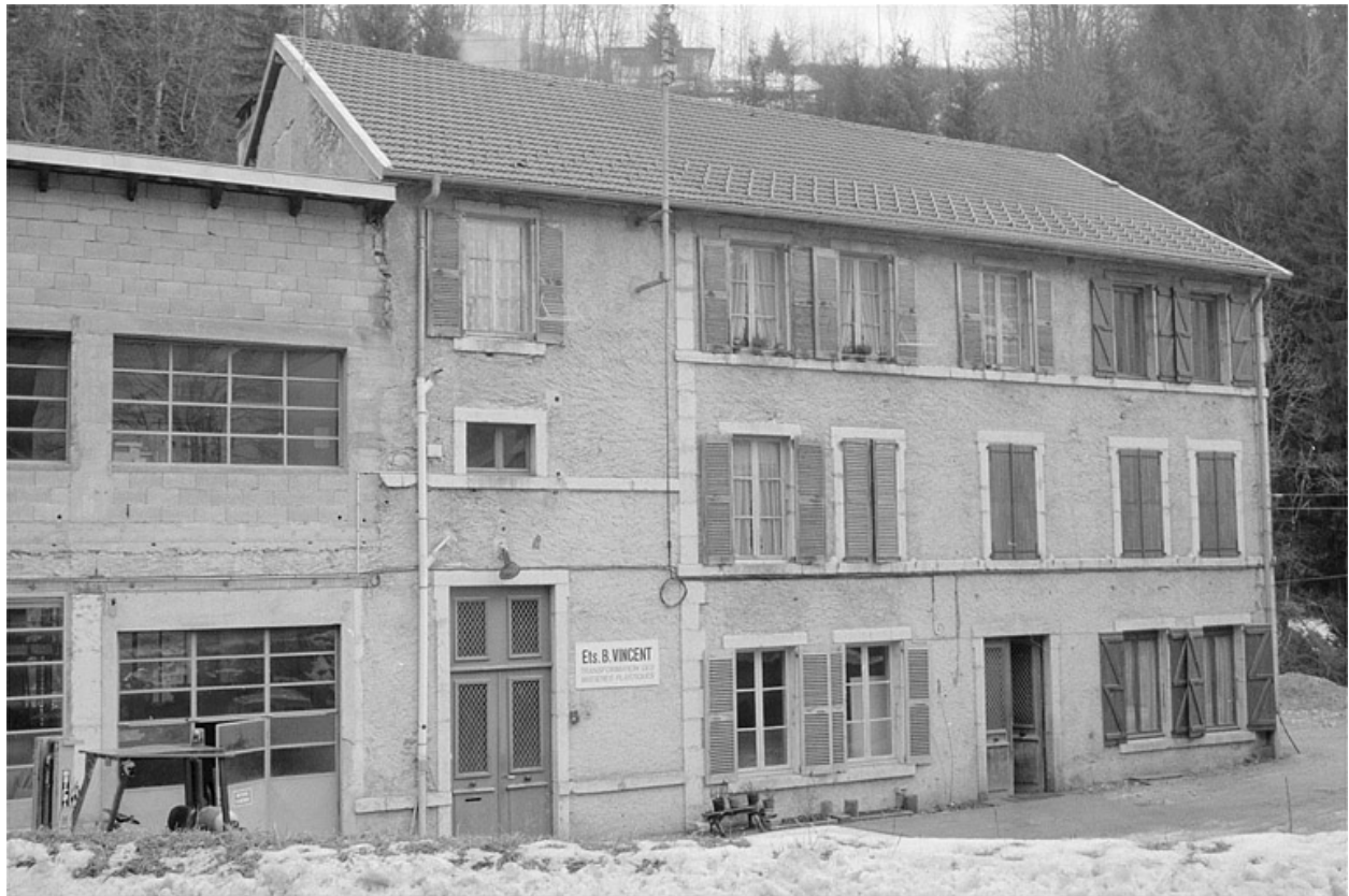
Bureau et logements.
