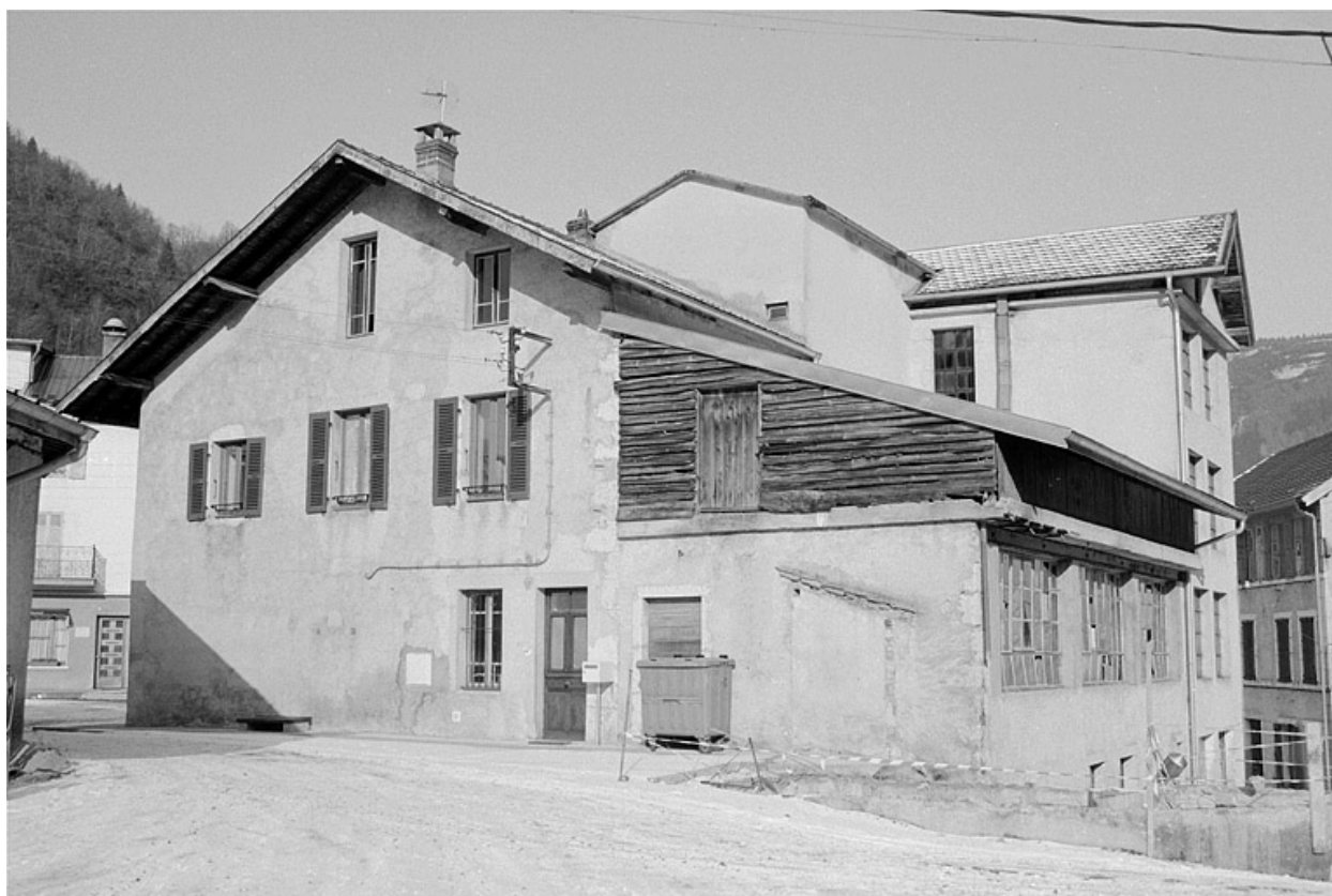
Minoterie, logements et atelier désaffecté.
