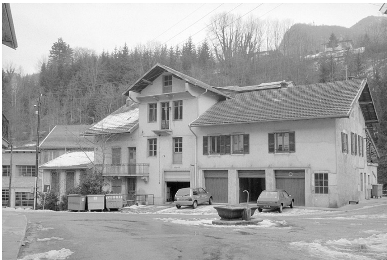
Minoterie et logements.
