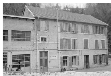
Bureau et logements.
