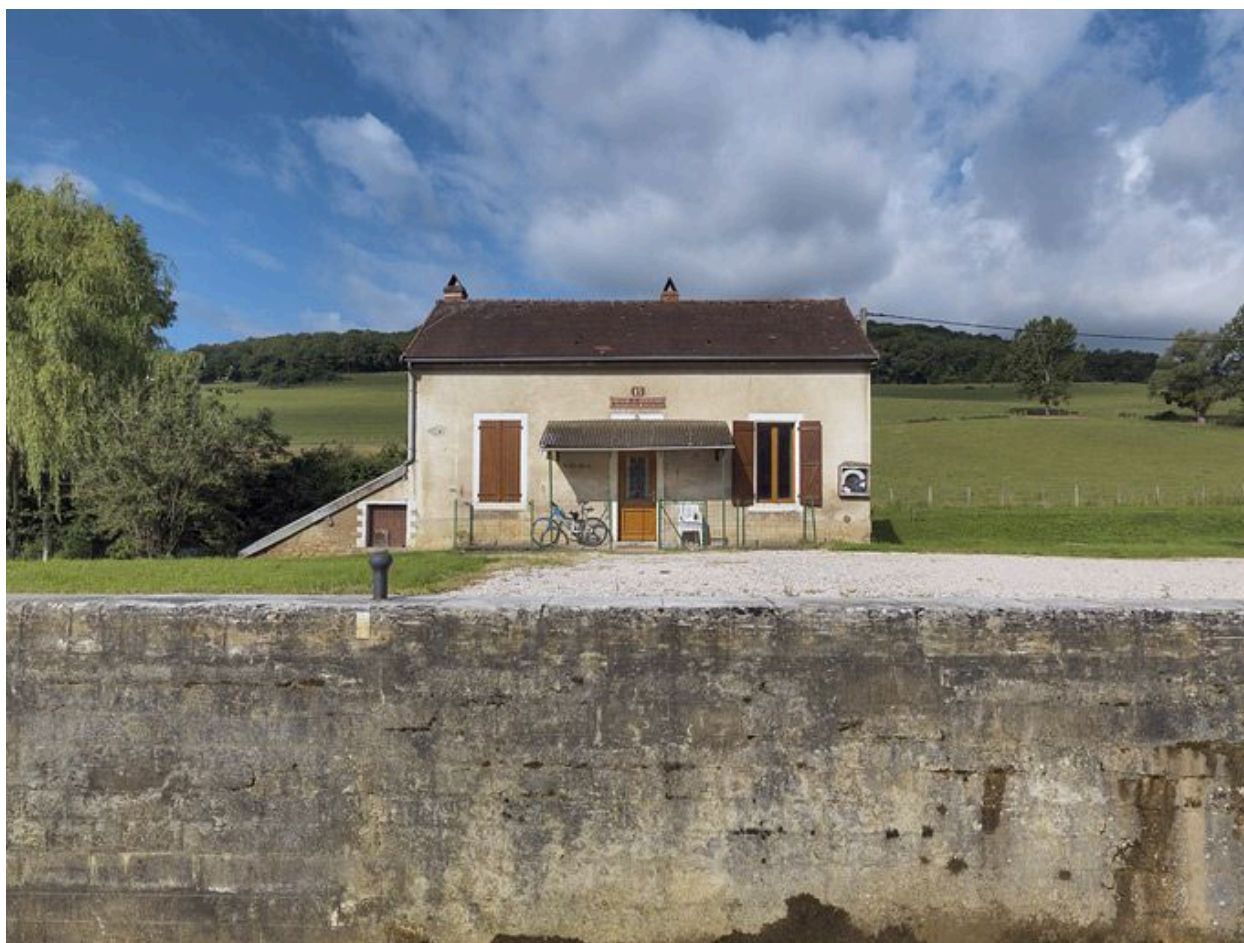
Maison éclusière de face.
