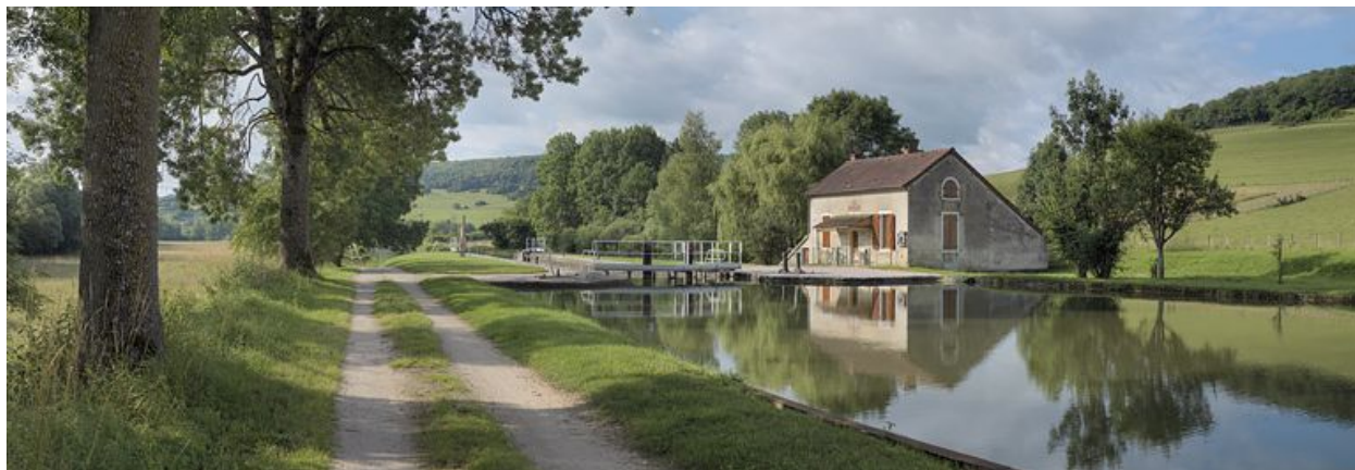
Site d'écluse vu d'amont.
