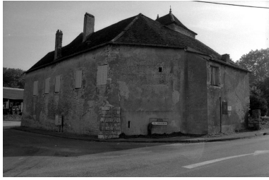
Façades sur rue. Phot. Bernard Lardière IVR43_19797000138Z
