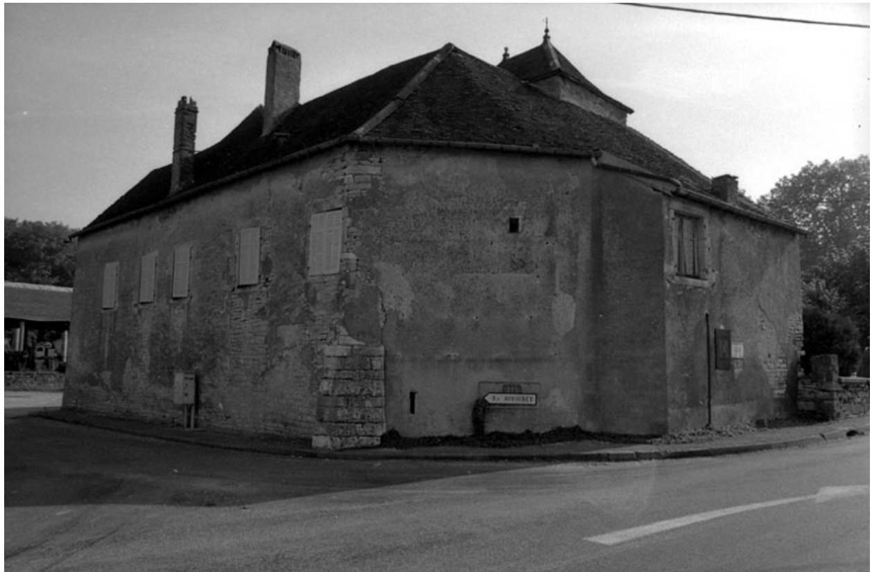
Façades sur rue.
