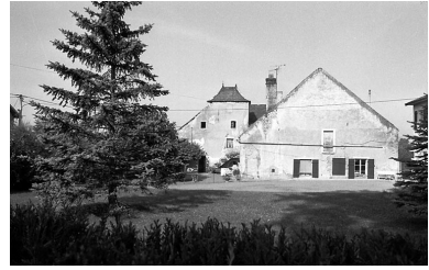
Façade latérale droite. Phot. Bernard Lardière IVR43_19797000140Z
