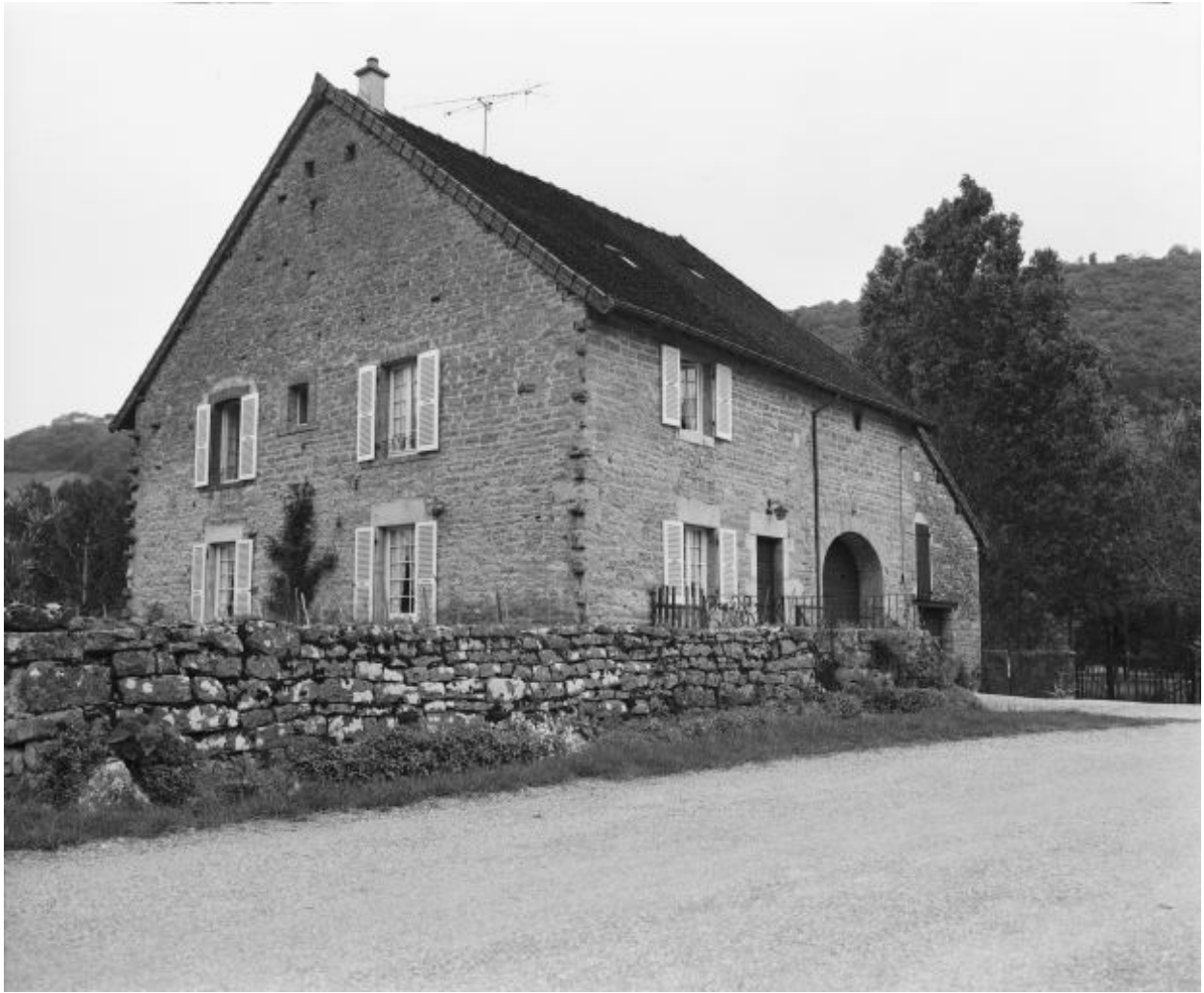
Façades antérieure et latérale droite.
