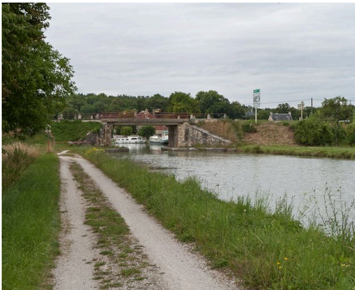
Vue du pont depuis l'amont.
