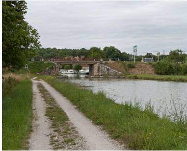
Vue du pont depuis l'amont. Phot. Pierre-Marie Barbe-Richaud IVR26_20118900344NUC4AQ
