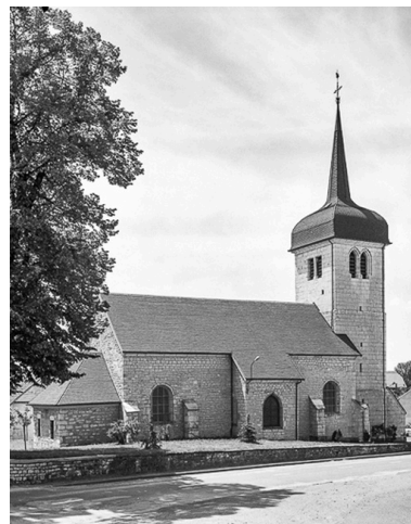
Extérieur : façade latérale gauche. Phot. Yves Sancey IVR43_19752500185V
