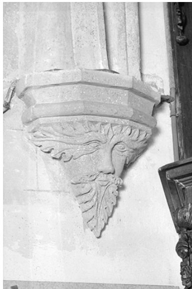
Culot. 1ère travée du choeur. Mur nord. Phot. Yves Sancey IVR43_19752500917Z
