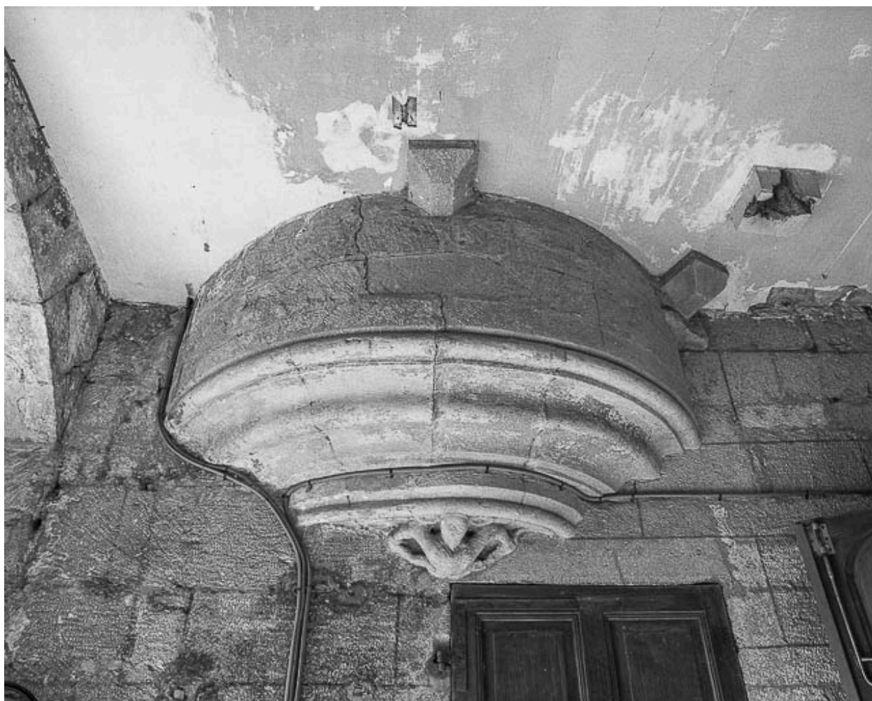
Base de l'escalier de la tour-clocher.
