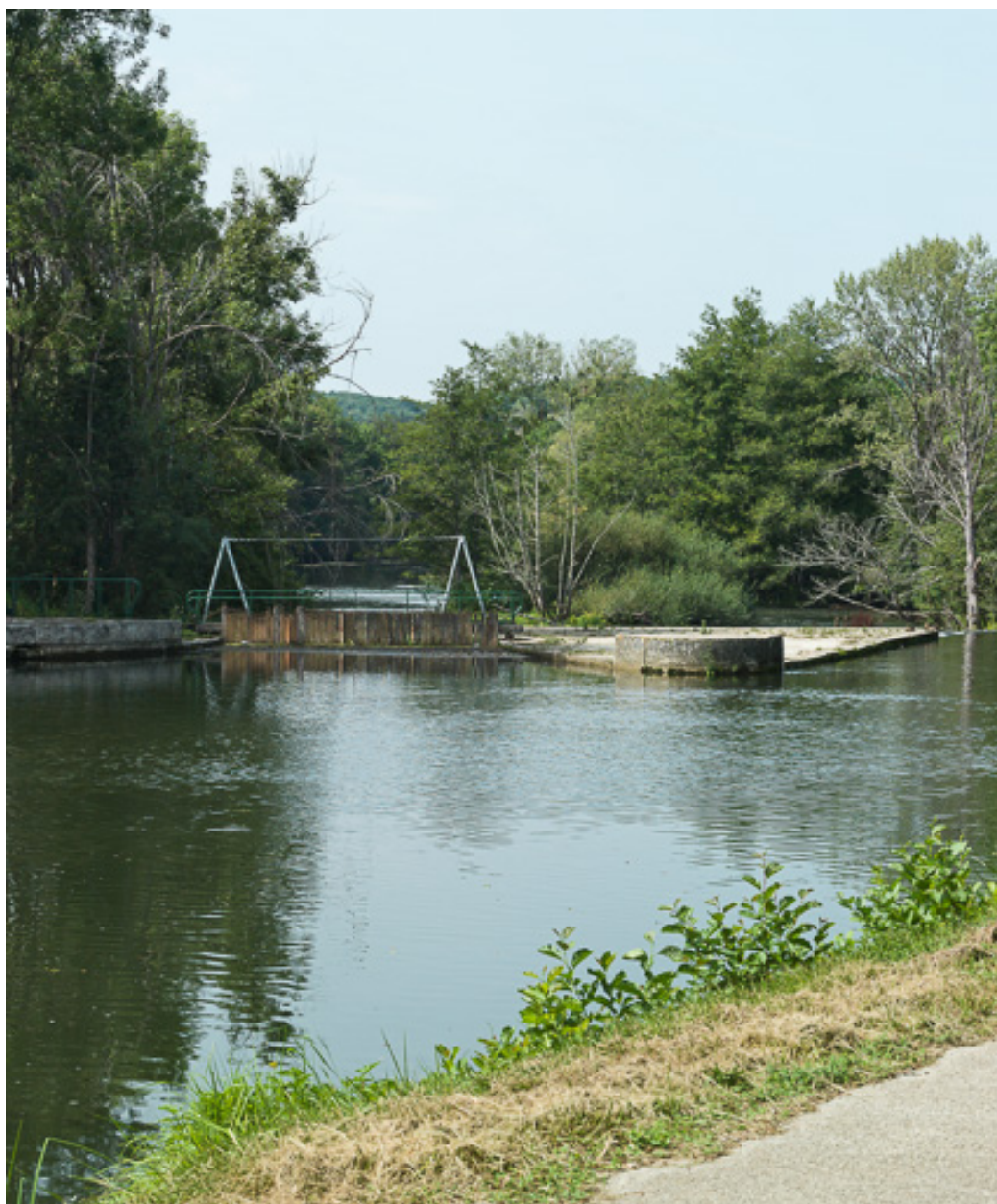
Vue du barrage.
