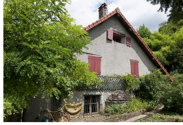
Façade latérale droite. Phot. Jérôme Mongreville IVR43_20102501298NUC4A
