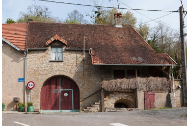
Façade antérieure. Phot. Jérôme Mongreville IVR43_20102500662NUC4A
