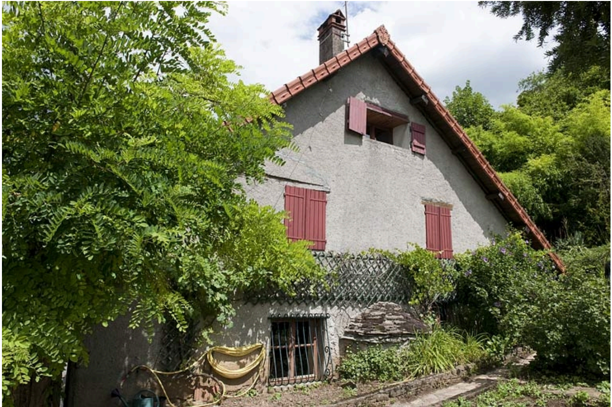
Façade latérale droite.
