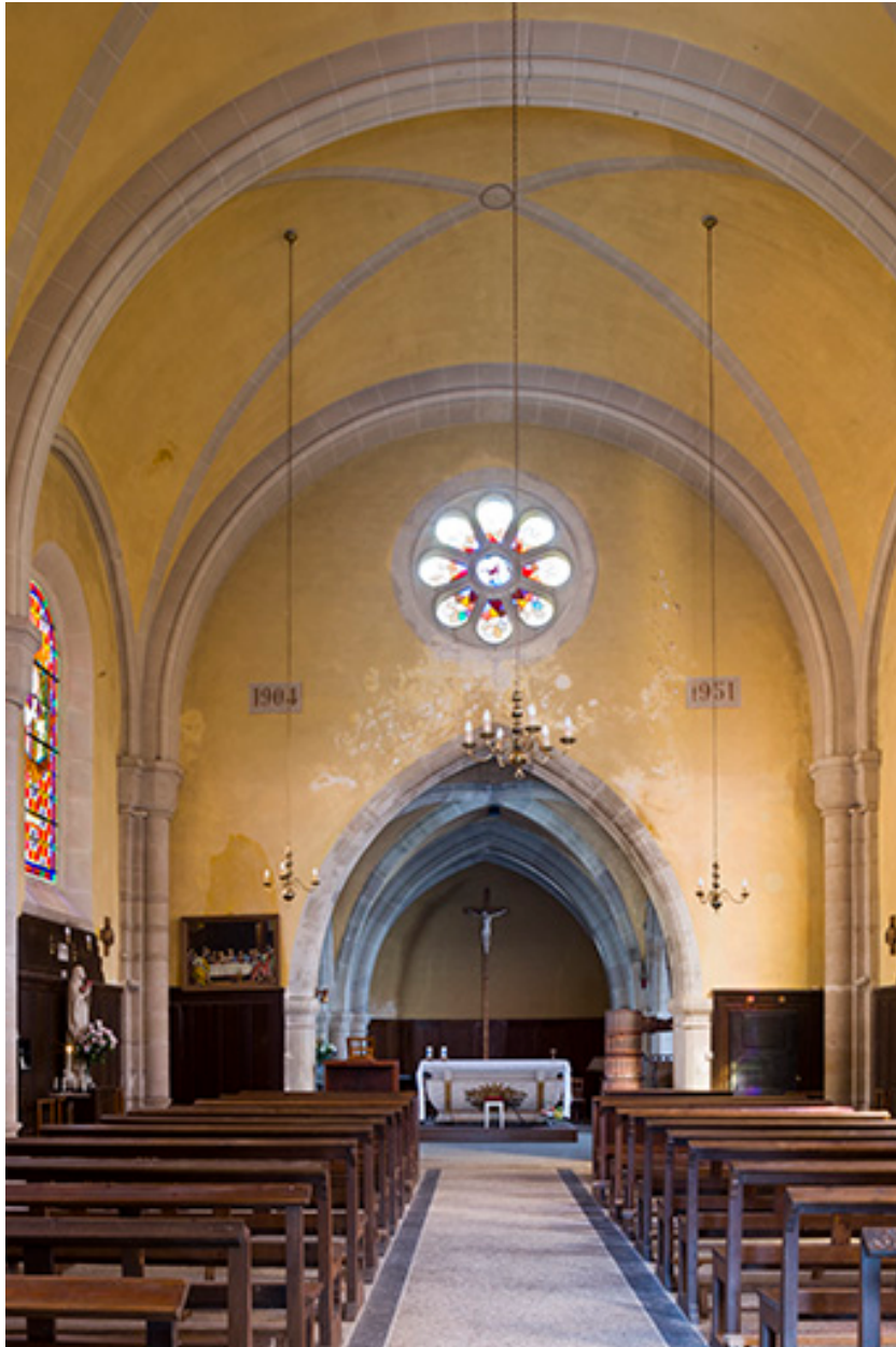
Le chœur et la nef depuis l'entrée.
