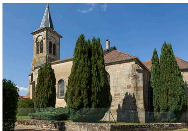
Façade latérale sud de la nef. Phot. Sonia Dourlot IVR43_20157001031NUC2A
