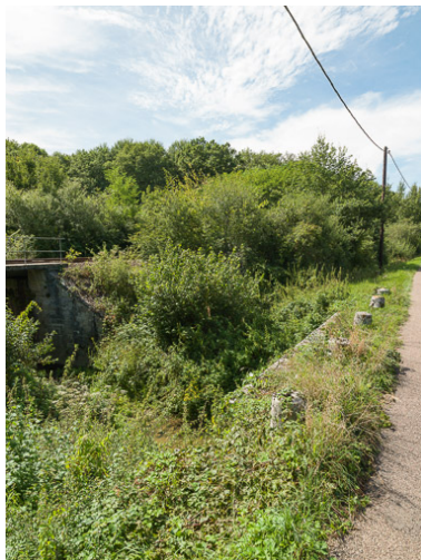
Vue de l'aqueduc. Phot. Pierre-Marie Barbe-Richaud IVR26_20175800362NUC2A
