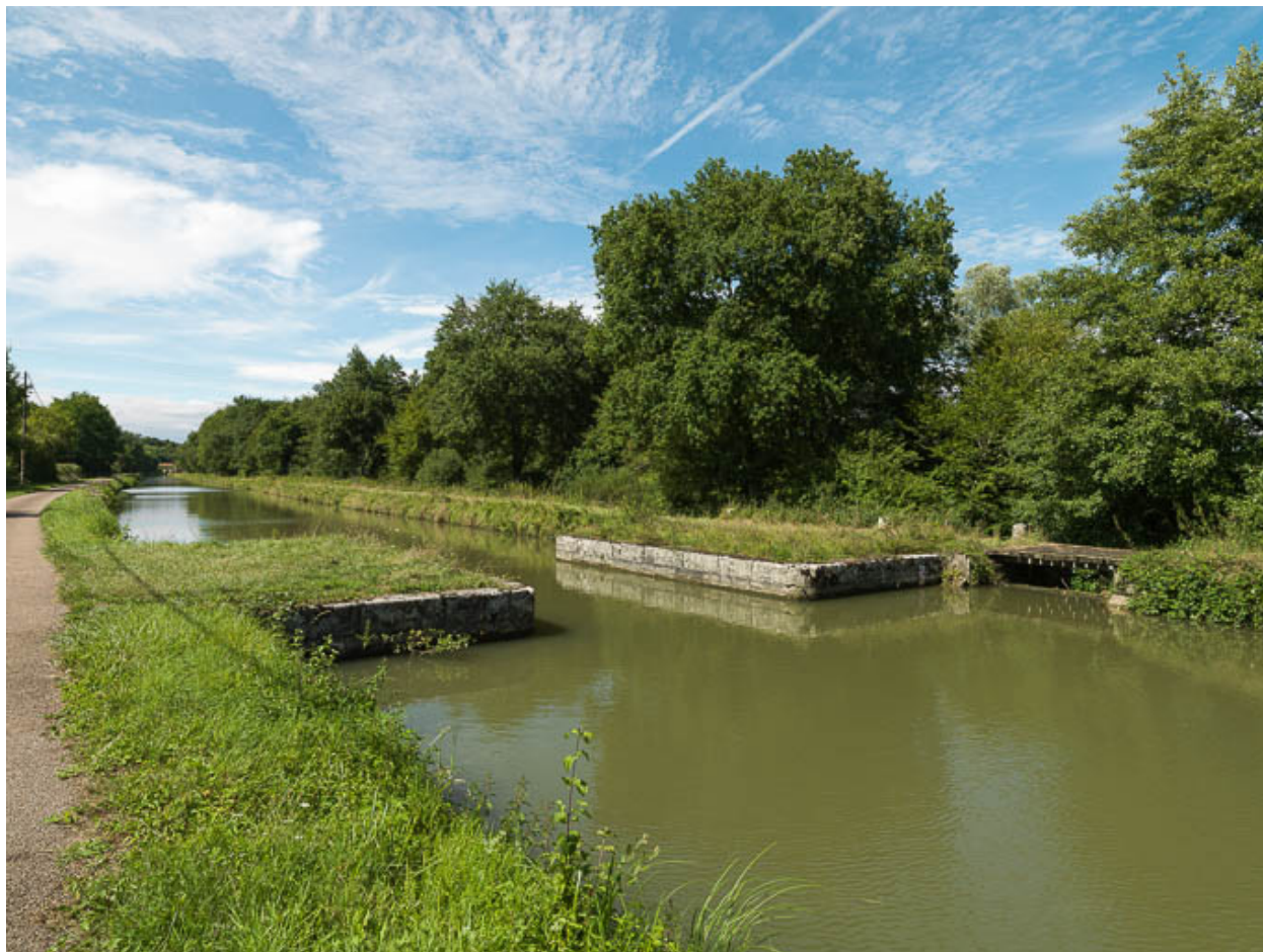
Vue du canal et du déversoir.
