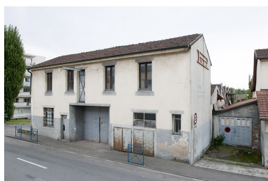
Bâtiment sur rue (logement ?).
