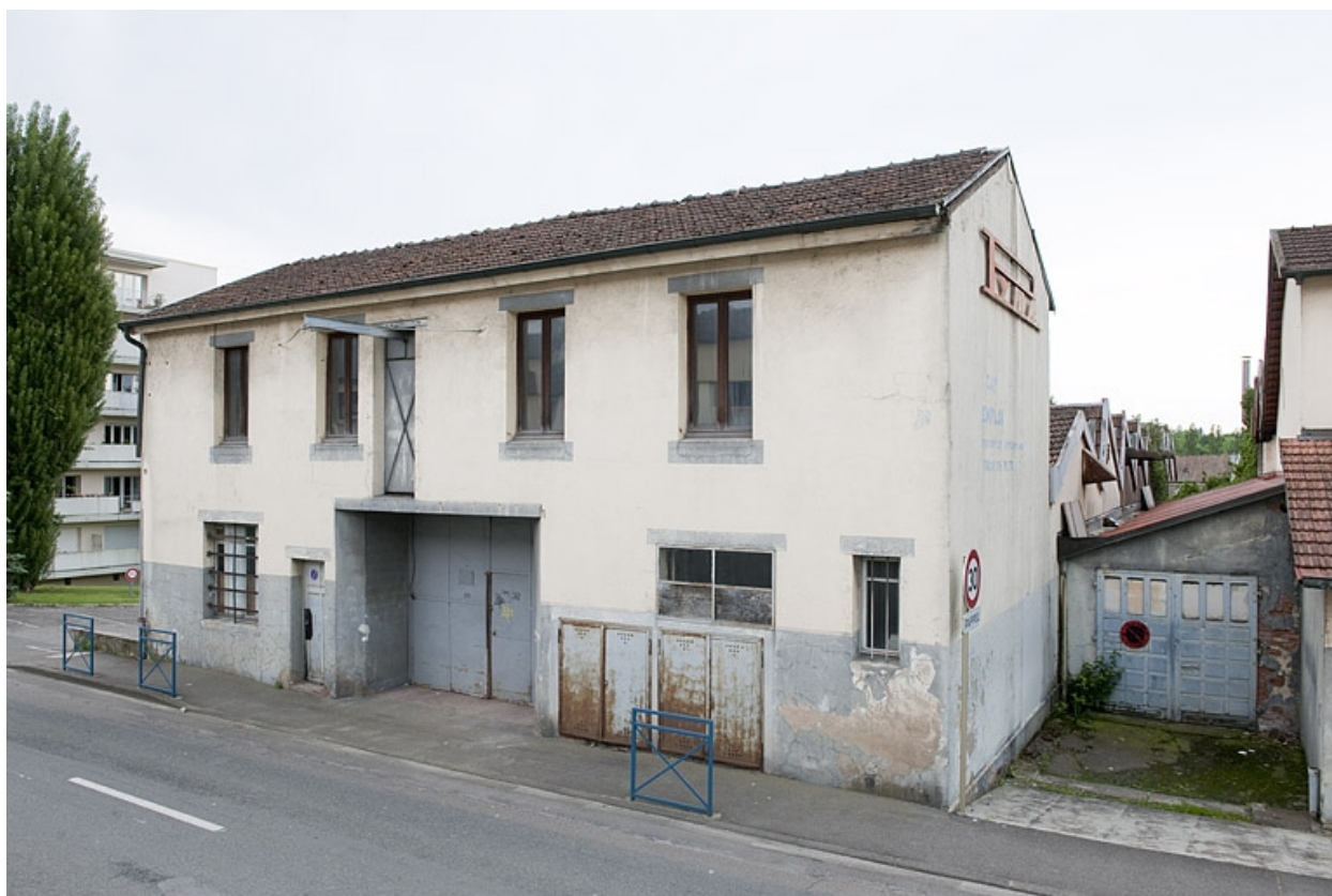
Bâtiment sur rue (logement ?).
