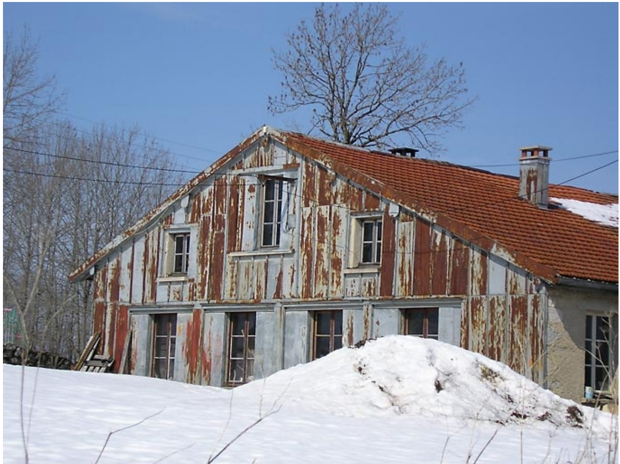
Vue du pignon sud-ouest.
