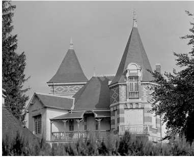
Vue générale. Phot. Yves Sancey IVR43_19853900319X
