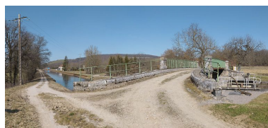
Le pont sur écluse vu d'amont. Phot. Thierry Kuntz IVR26_20122102585NUC4A
