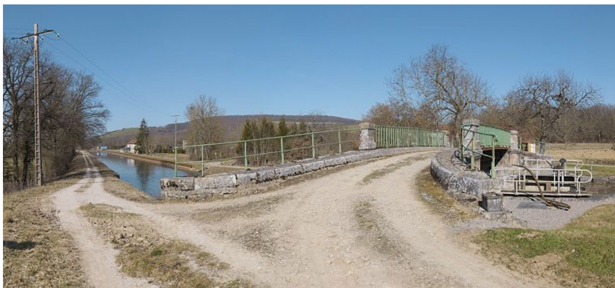
Le pont sur écluse vu d'amont.
