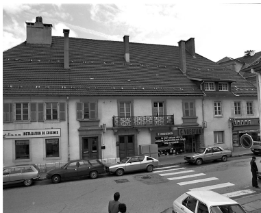
Façade sur rue. Phot. Yves Sancey
