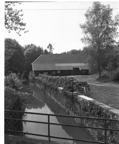
Le canal et la halle à charbon en 1989. Phot. Yves Sancey IVR43_19897000672X
