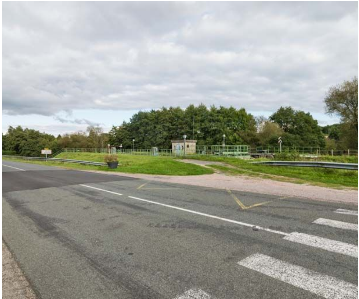
Vue d'ensemble du site d'écluse.
