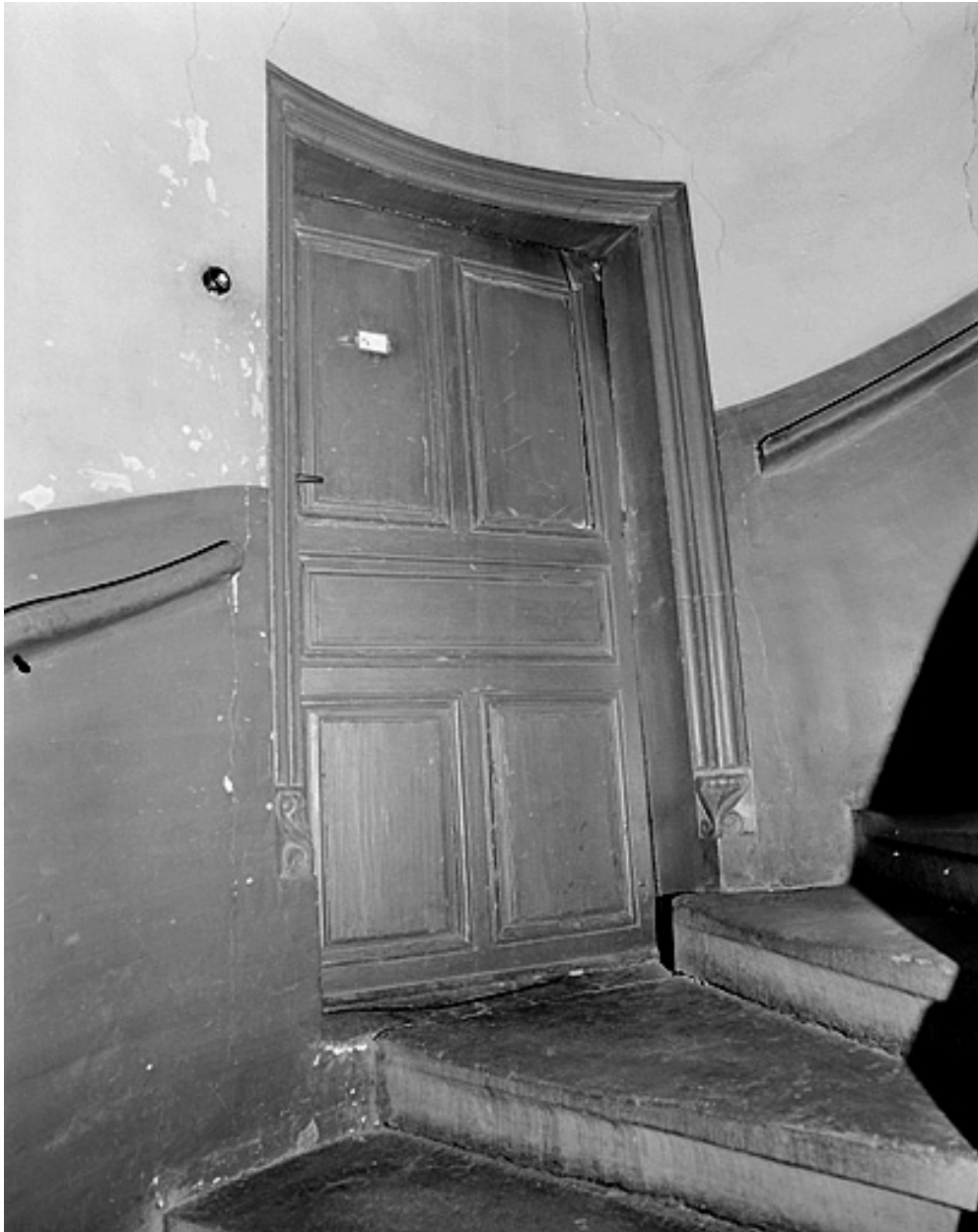
Escalier. Porte du deuxième étage.
