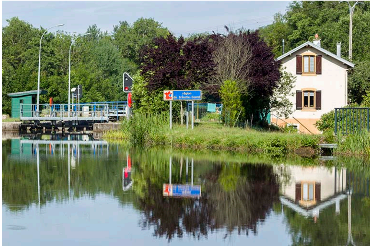
Vue d'ensemble depuis l'amont.
