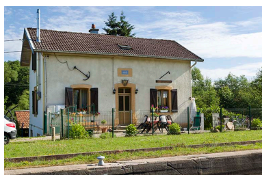
La maison d'éclusier, depuis l'écluse. Phot. Sonia Dourlot IVR43_20157000887NUC2A
