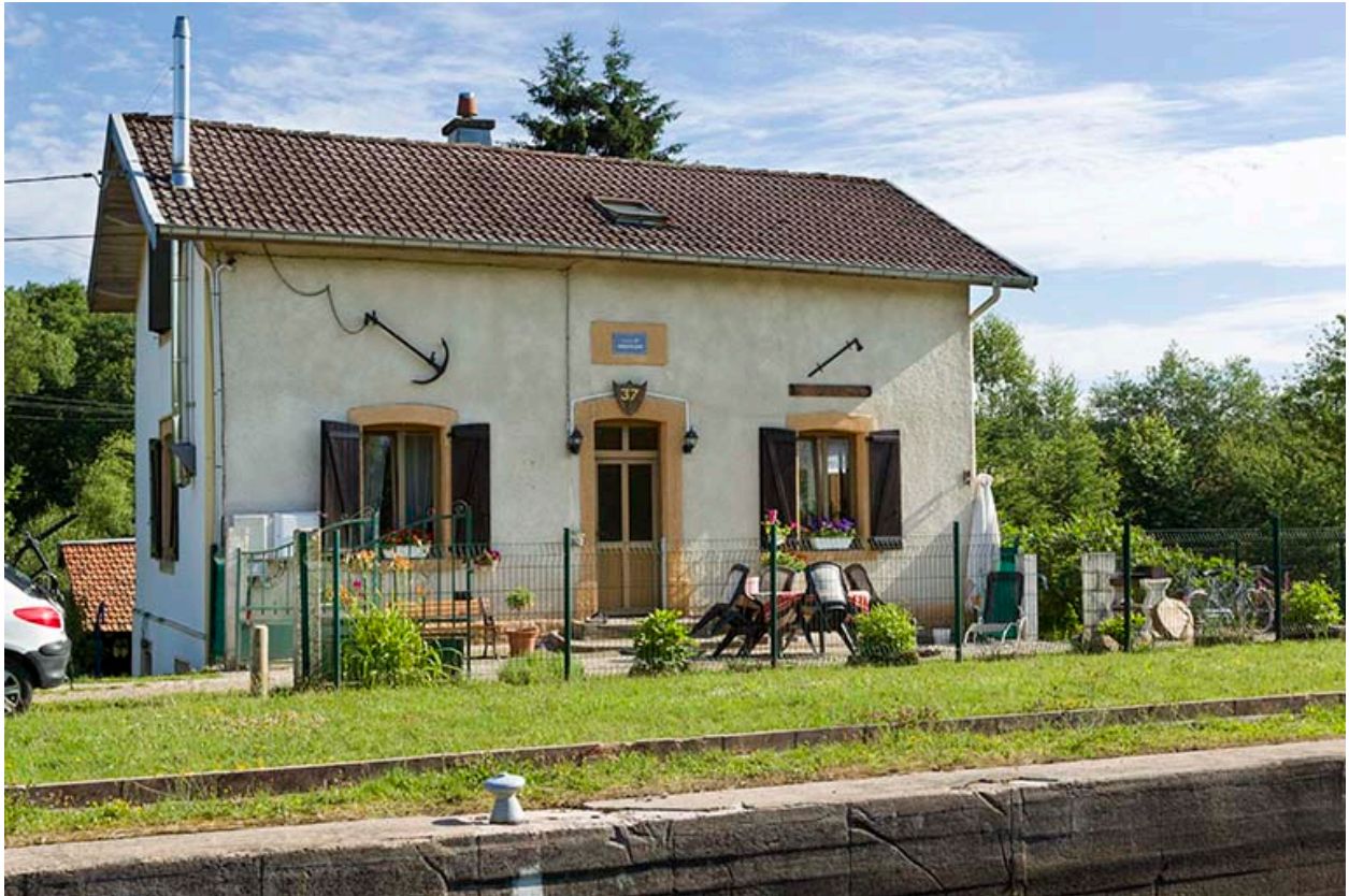
La maison d'éclusier, depuis l'écluse.
