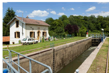
Le site d'écluse, depuis l'aval. Phot. Sonia Dourlot IVR43_20157000886NUC2A
