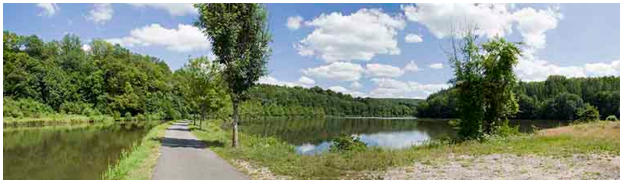
Vue en amont de l'écluse.
