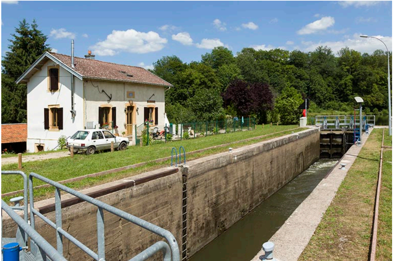
Le site d'écluse, depuis l'aval.
