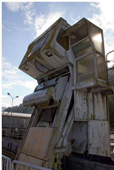
Prise d'eau : le dégrilleur, de trois quarts droite. Phot. Yves Sancey IVR43_20122501999NUC2A
