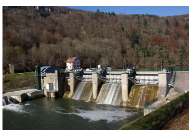
Vue d'ensemble depuis le sud-est (aval rive gauche).
