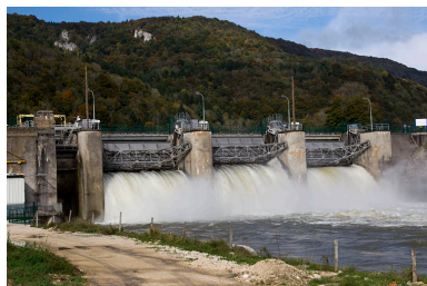
Barrage depuis la rive droite en aval, en période de crue. Phot. Yves Sancey IVR43_20122501994NUC2A
