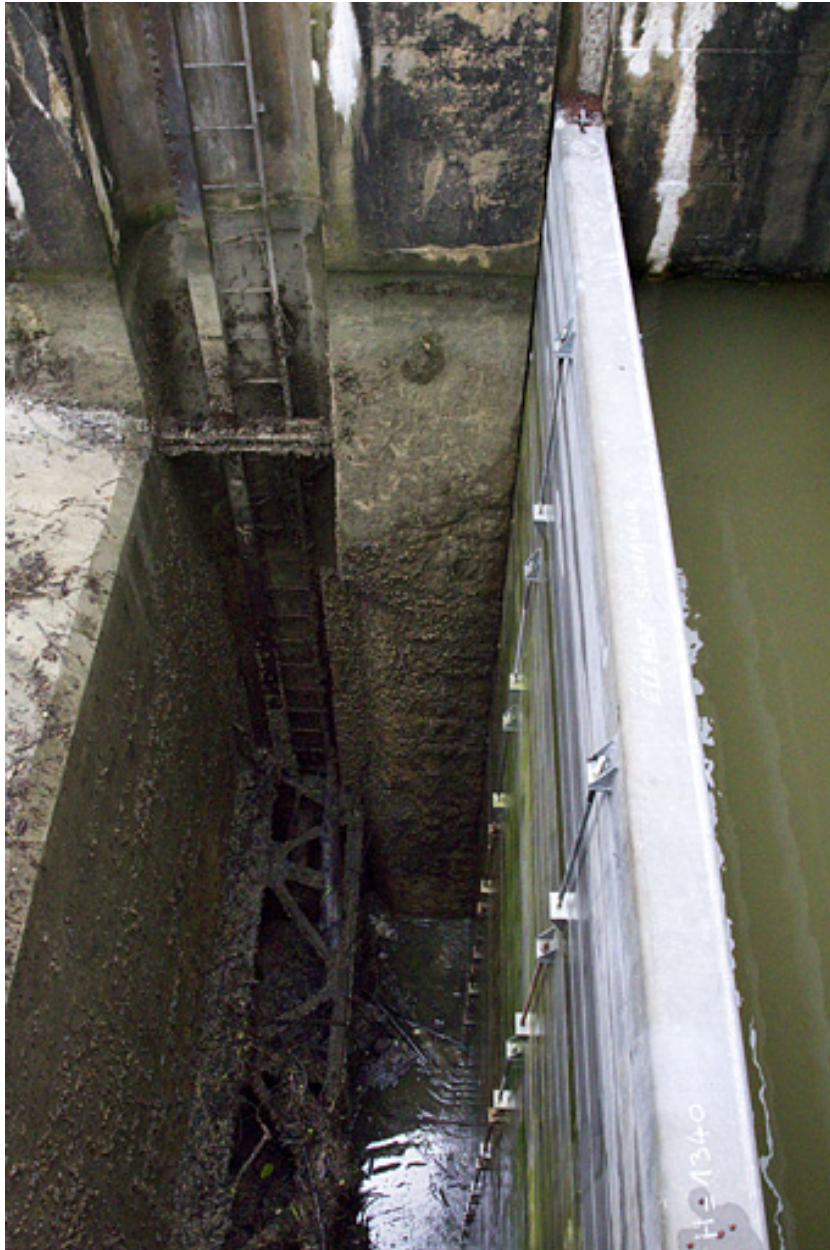
Barrage : batardeau protégeant la vanne clapet en réparation.
