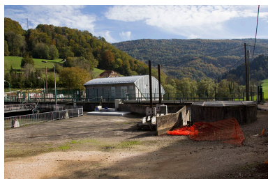
Prise d'eau : commande des vannes de protection. Phot. Yves Sancey IVR43_20122501996NUC2A
