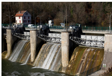
Barrage depuis la rive gauche en aval. Phot. Yves Sancey IVR43_20122502001NUC2A
