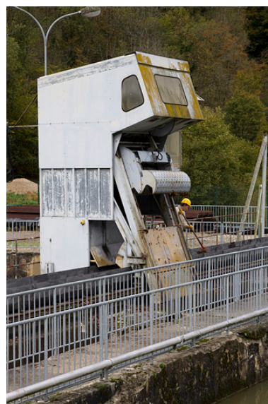
Prise d'eau : le dégrilleur, de trois quarts gauche. Phot. Yves Sancey IVR43_20122501998NUC2A
