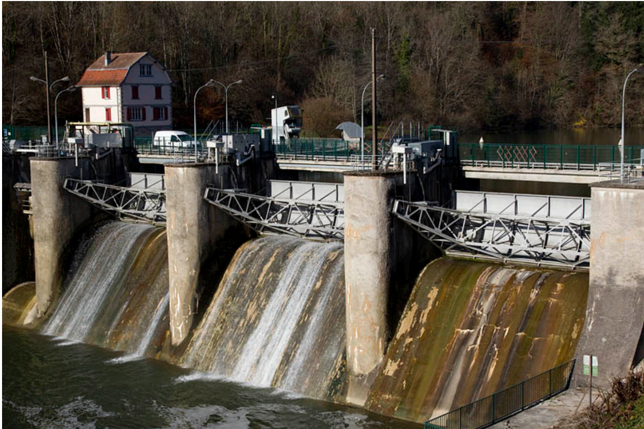
Barrage depuis la rive gauche en aval.
