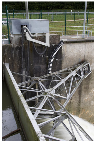
Barrage : système d'ouverture d'une vanne secteur (vanne évacuateur de crue). Phot. Yves Sancey IVR43_20122501982NUC2A
