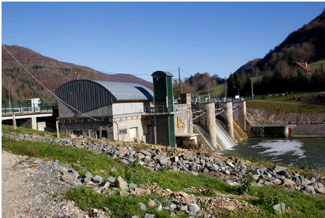
Centrale et ascenseur à poisson.
