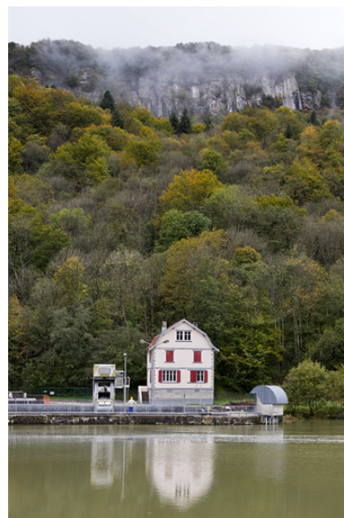
Logement du garde. Phot. Yves Sancey IVR43_20122501978NUC2A
