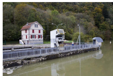
Prise d'eau : grilles de protection du bassin et dégrilleur. Phot. Yves Sancey IVR43_20122501979NUC2A
