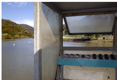
Prise d'eau : poste de commande du dégrilleur. Phot. Yves Sancey IVR43_20122501997NUC2A
