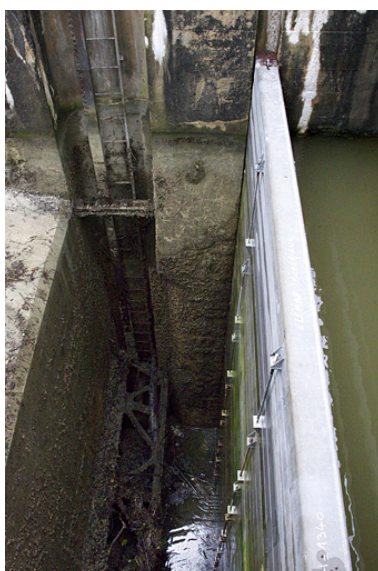
Barrage : batardéau protégeant la vanne clapet en réparation. Phot. Yves Sancey IVR43_20122501984NUC2A
