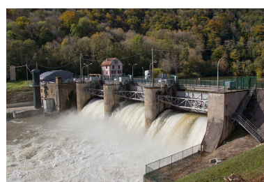
Vue d'ensemble depuis le sud-est, en période de crue.
