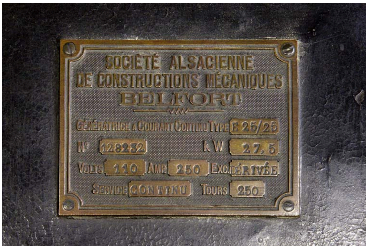
Centrale : plaque signalétique de l'excitatrice.
