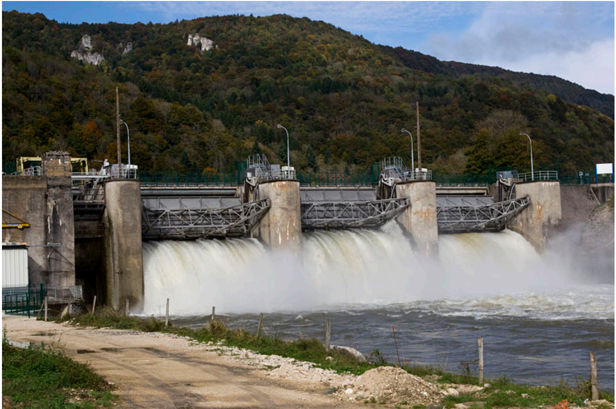
Barrage depuis la rive droite en aval, en période de crue.
