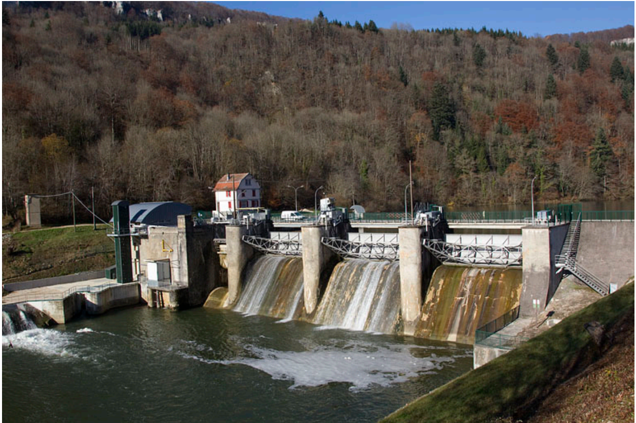
Vue d'ensemble depuis le sud-est (aval rive gauche).
