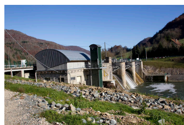
Centrale et ascenseur à poisson. Phot. Yves Sancey IVR43_20122502004NUC2A
