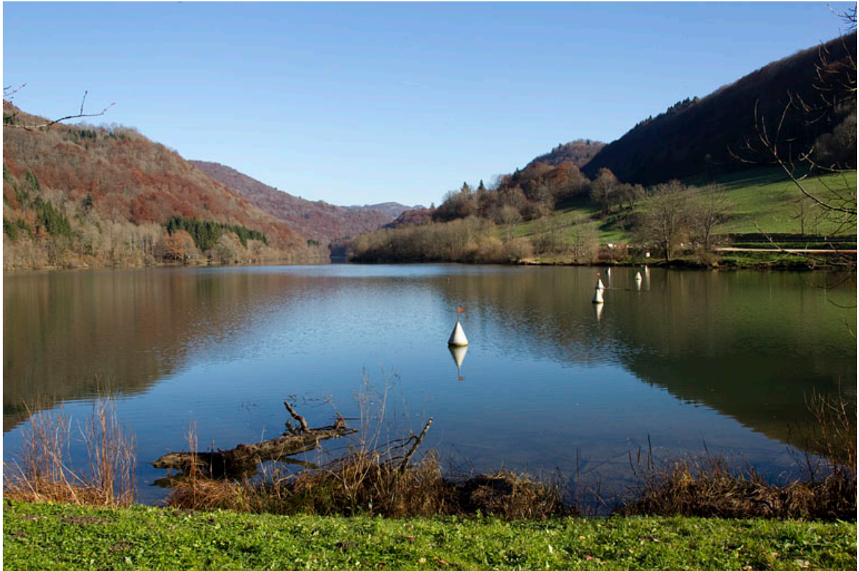
Bassin de retenue depuis la rive droite.
