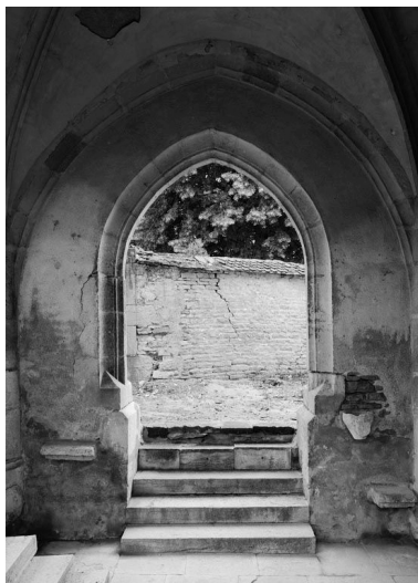
Mur gauche du porche. Phot. Michel Rosso IVR26_19792100133V
