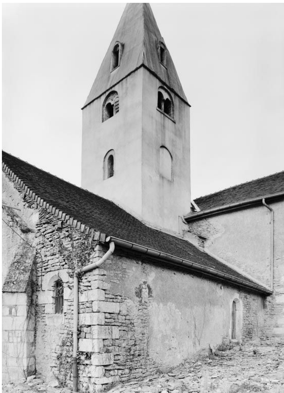
Elévation gauche du choeur et clocher.
