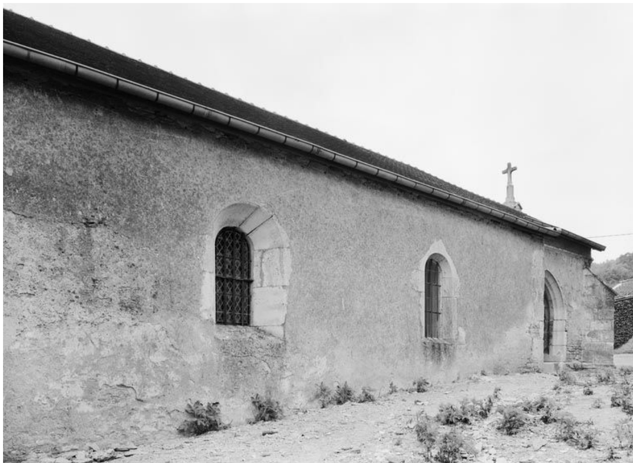
Elévation gauche de la nef.
