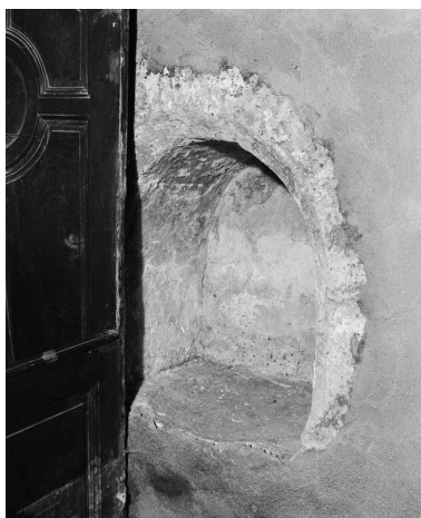
Lavabo du mur droit du chœur. Phot. Michel Thierry IVR26_19792100152X
