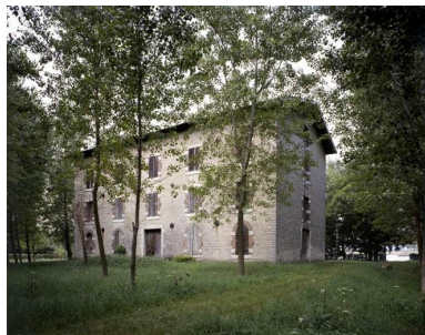
Elévations antérieure et droite. Phot. Michel Rosso IVR26_19882102771VA
