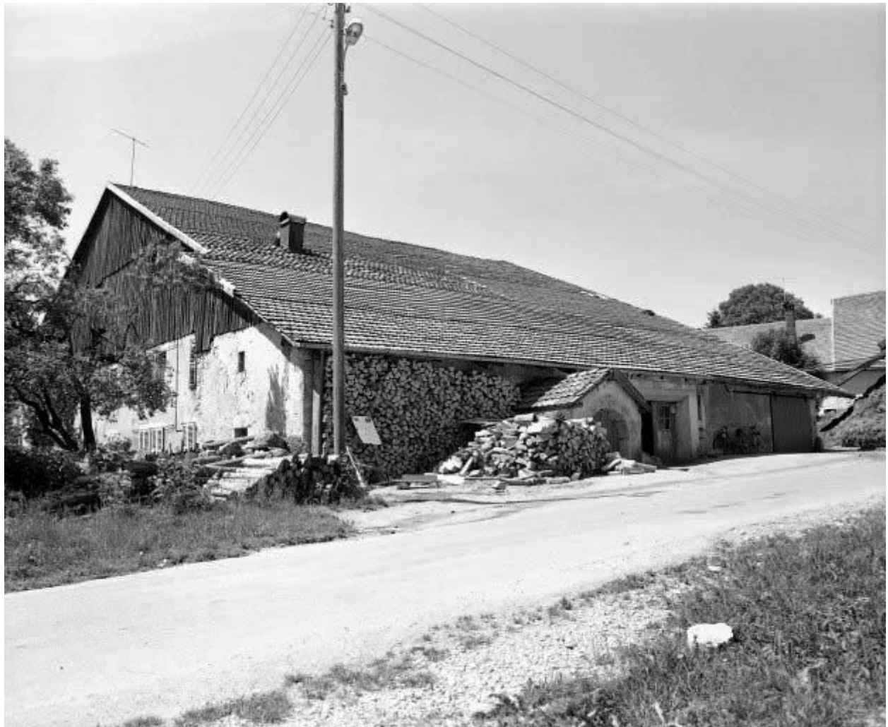
Facades antérieure et latérale droite.
